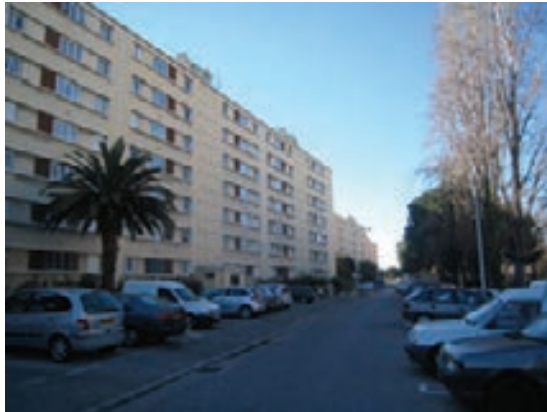
Figure 7: Photo résidence des Sagnes (Source : Egis France)
