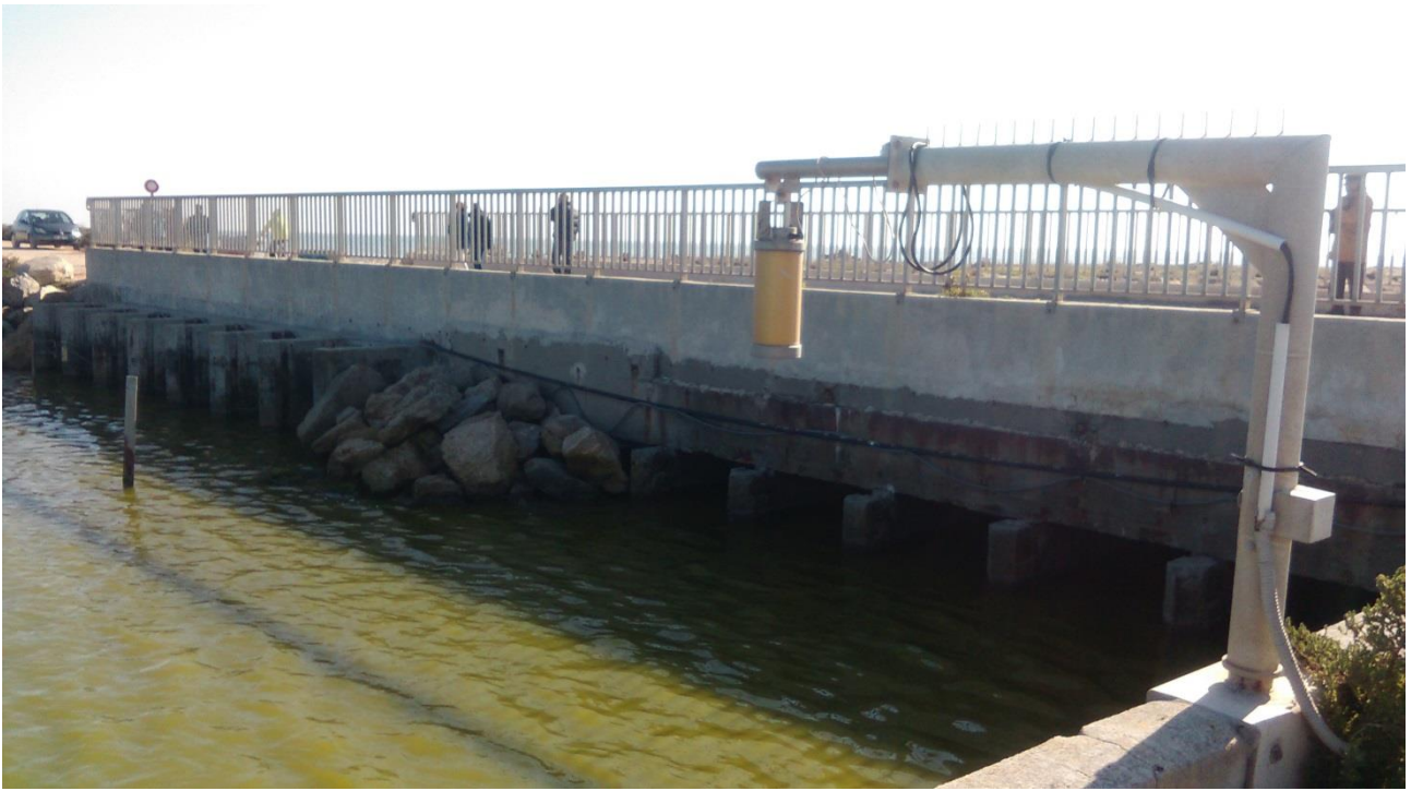
Situation du projet dans l'environnement proche (vue de l'amont du pertuis)
