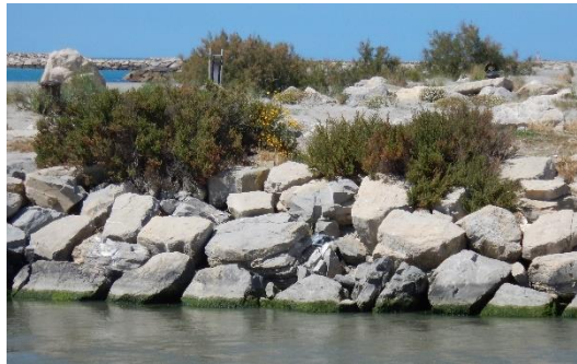
Figure 8 : Enrochements rive droite (BRL i, 2016)
