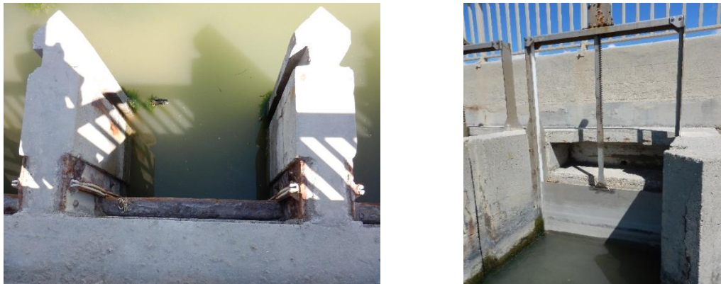
Figure 5 : à gauche glissière des anciennes martellières amont et à droite martellière numéro 1 (BRL i, 2016)
