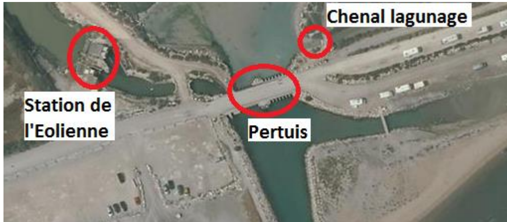
Figure 13 : Environnement immédiat du pertuis de la Fourcade
