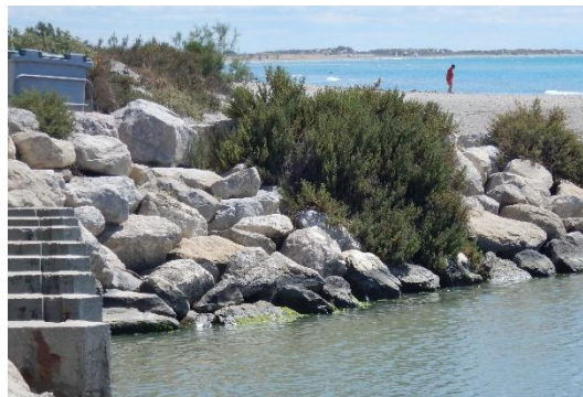
Figure 4 : Enrochements rive gauche (BRL i, 2016)
