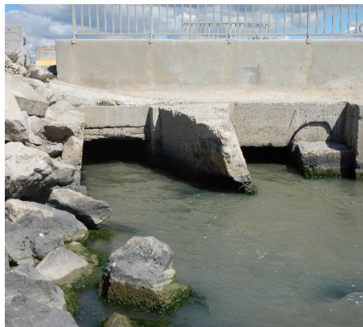
Figure 6 : Dalots béton E1 et E2 (BRL i, 2016)
