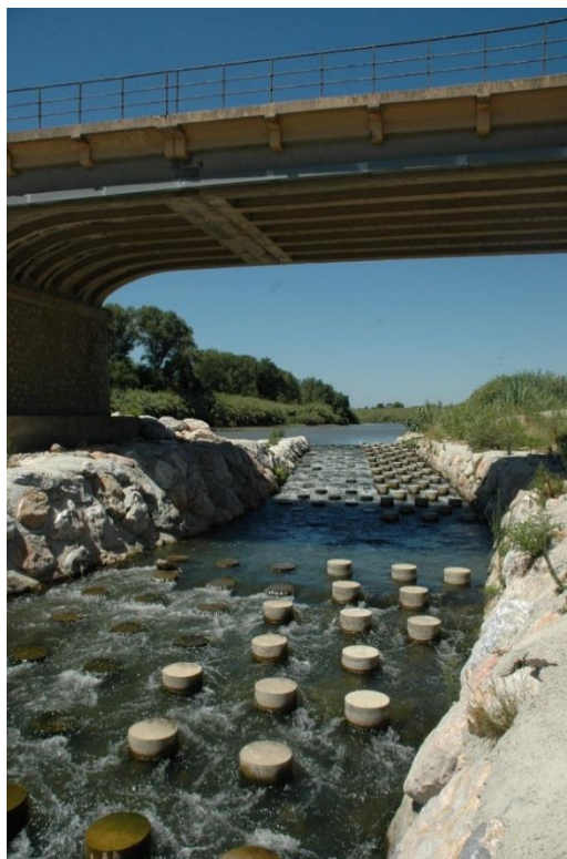
Figure 39 : Passe à macro-rugosité au droit du seuil de Canet en Roussillon, Dimensionnement réalisé par BRL Ingénierie, Pyrénées orientales, CG66
