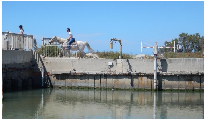
Figure 15 : Mur béton berge amont rive droite (BRL i, 2016)
