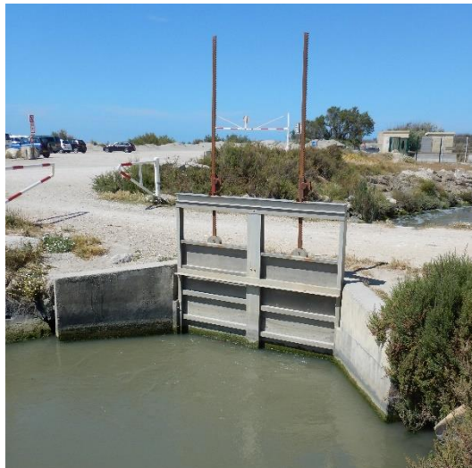
Figure 17 : Martellières du chenal de rejet de la station de l'éolienne (BRL i, 2016)
