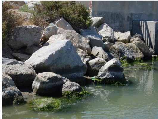
Figure 14 : Enrochements berge amont rive gauche (BRL i, 2016)
