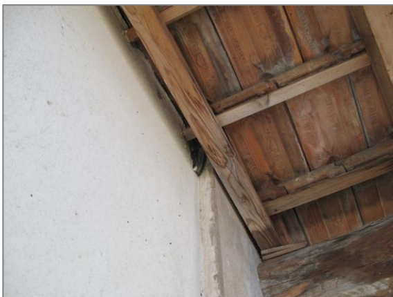
Gîte de chauves-souris en façade (terrasse à l'étage) de la bâtisse principale
