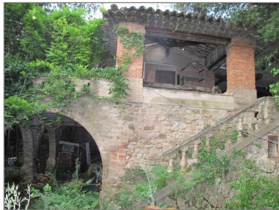
Bâtiment abandonné, gîte possible pour les chauves-souris mais pas d'observations
