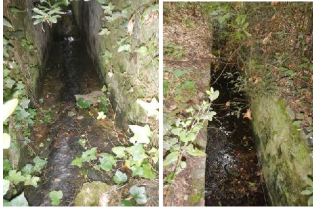
Ouvrage cadre et fossé allant sous la voie ferrée
