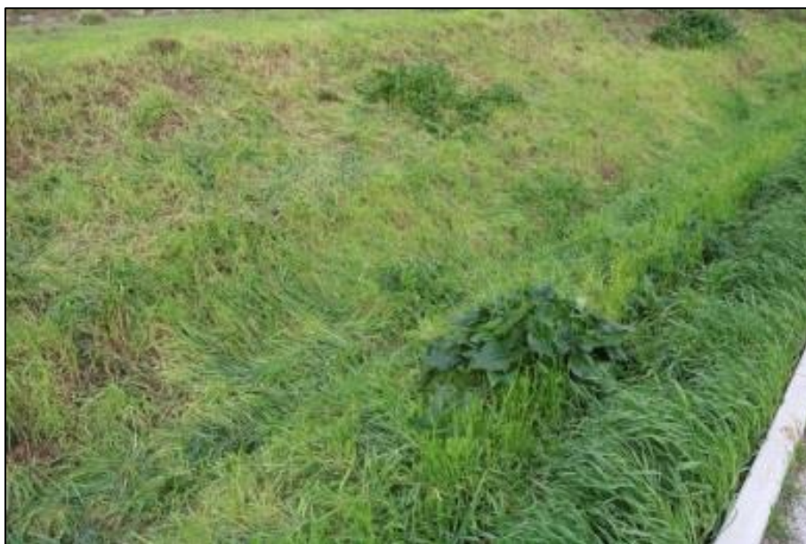
Photo 7: Fossés présents sur le pourtour du secteur d'étude (FL, mars 2017)
