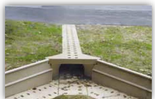
Figure 22 : Photo d'un exemple de batrachoduc (source : ACCO crapauduc)
