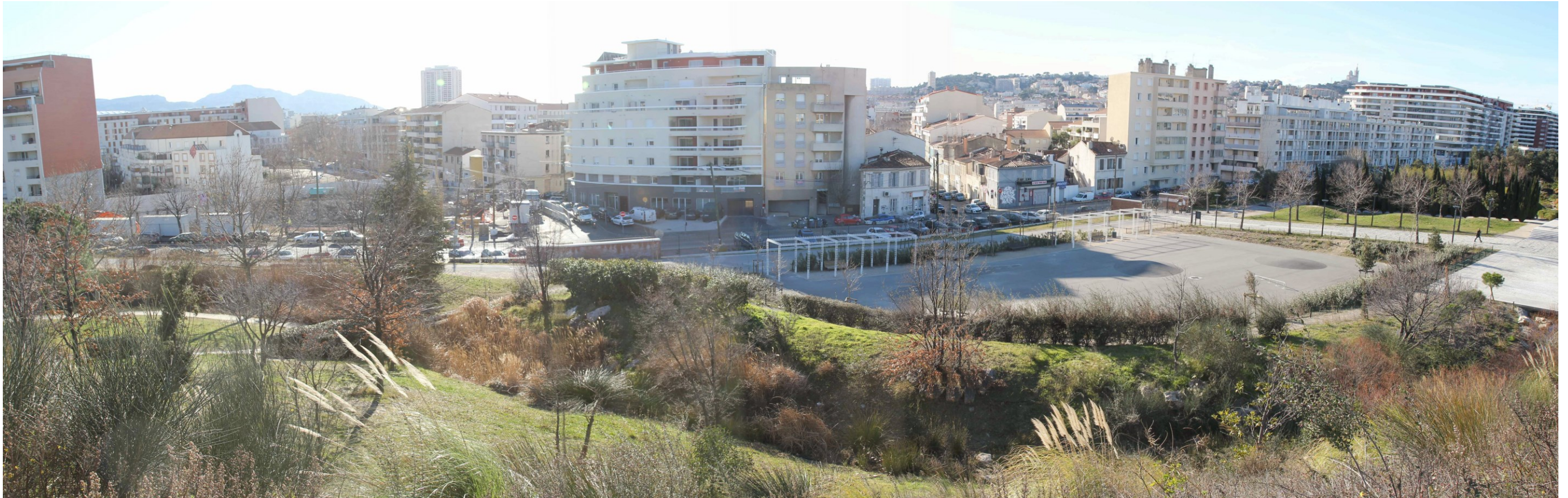
Vue 9 dans le parc (point de vue au centre du parc) vers la future zone de travaux (sous le Skate Park) (janvier 2018)
