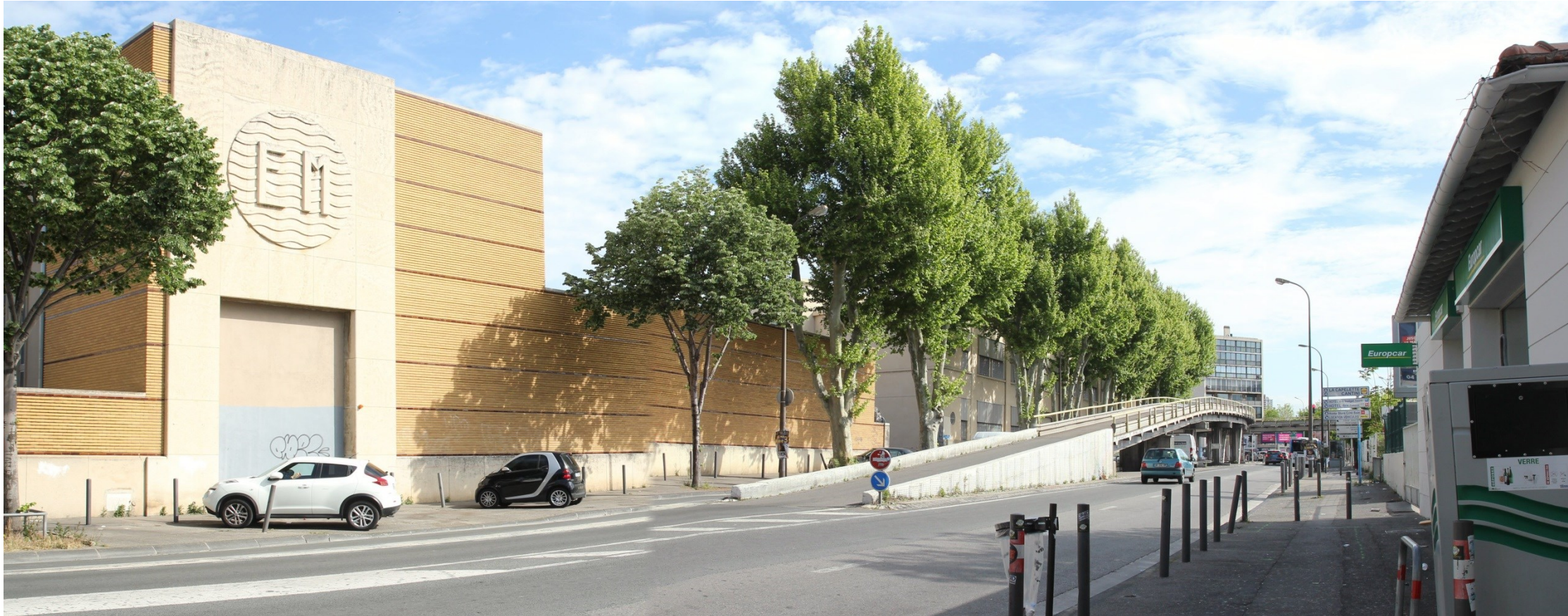
Vue 10 sortie de passerelles vues depuis le Bd Rabatau sud (mai 2017)
