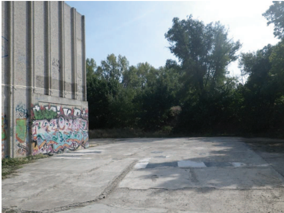
Photo 5 : Vue sur le bâtiment à l'Est du parking
