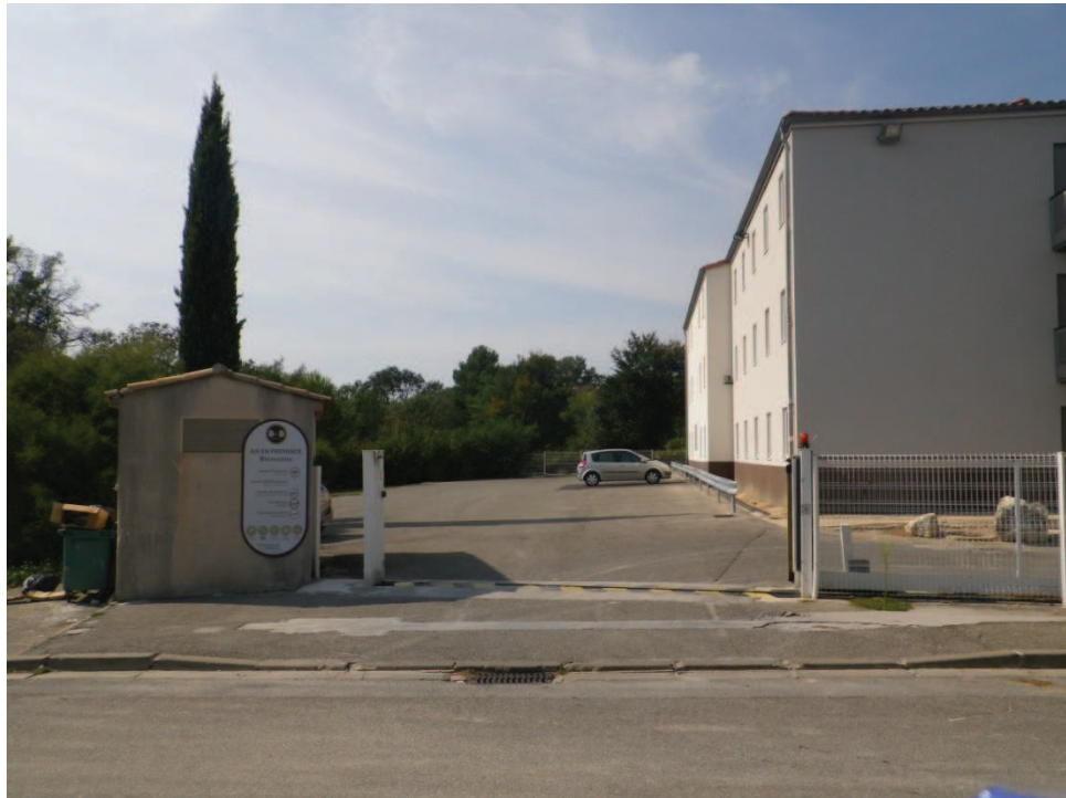
Photo 3 : Vue de l'hôtel situé à l'ouest du parking
