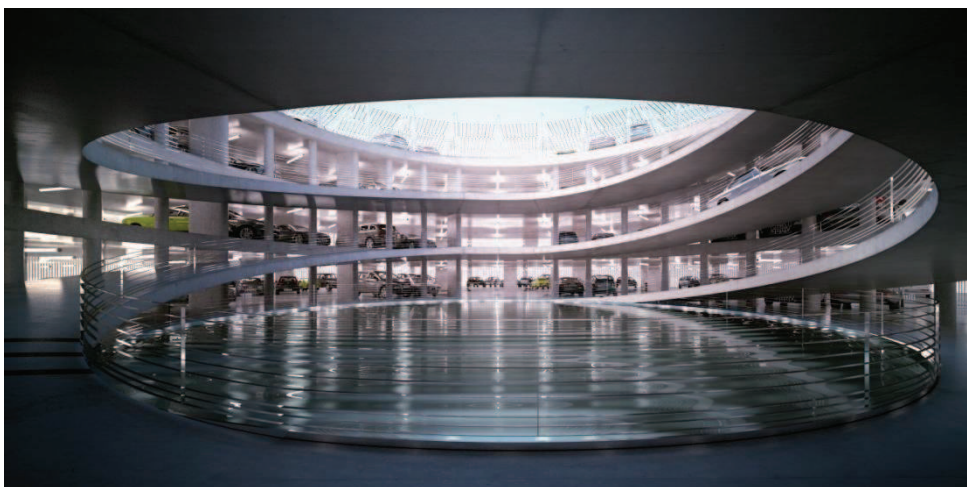
FIGURE 33 : VUE INTERIEURE DU PARKING
