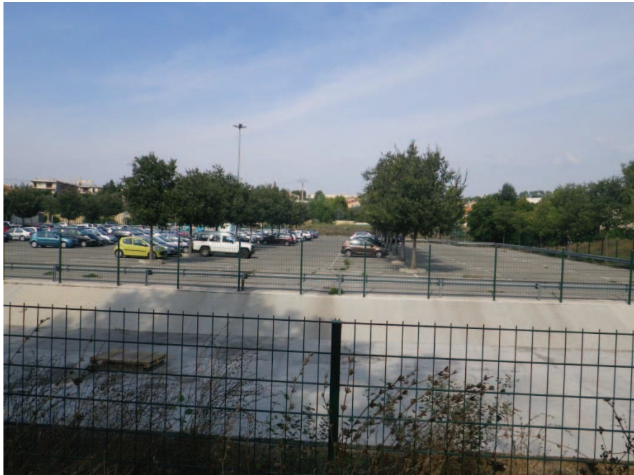
Photo 1 : Vue sur le Sud du parking (bassin de rétention au premier plan)
