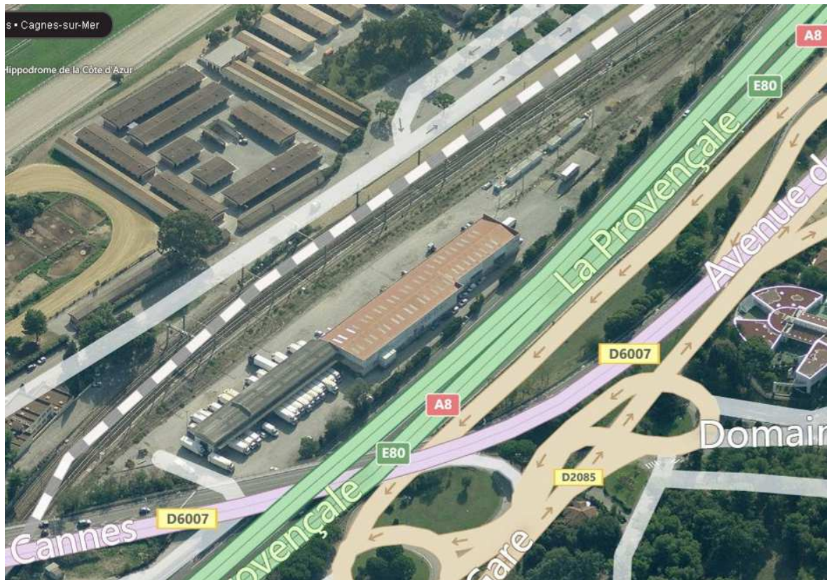
Figure 28 : Vue actuelle du site de la station de traitement future
