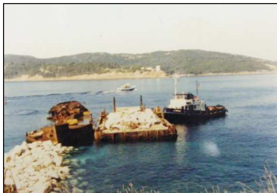
Mise en place des enrochements en 1986 (photo Philippe Fourneau)
