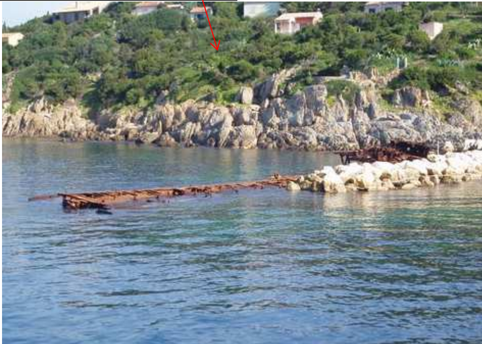
Zoom sur la reprise de la digue en enrochement et la réalisation du tenon (PTP 22-01-2014) - Illustrations de la digue dans son état actuel
