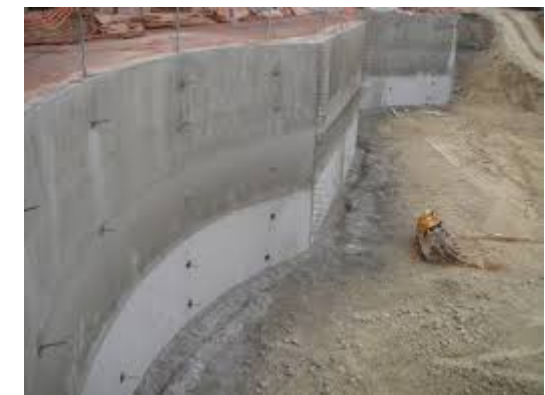
Exemples de paroi clouée avec et sans fruit
