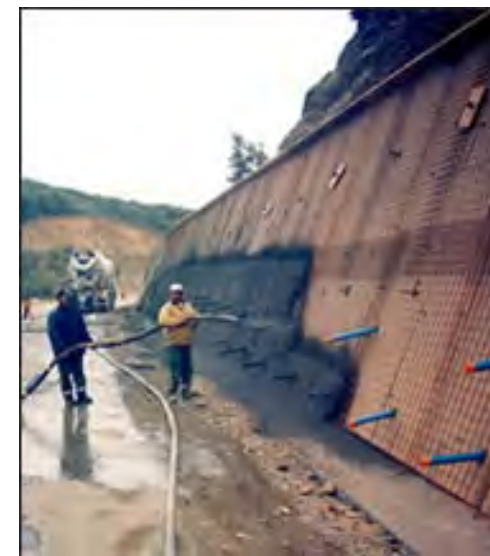
Exemples de paroi clouée avec et sans fruit
