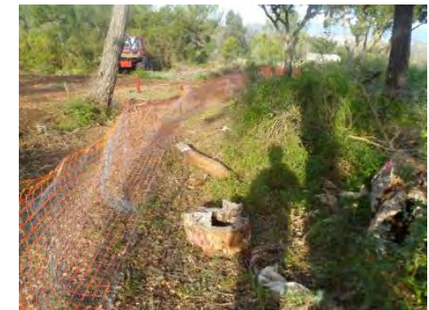
Figure 12 : Exemple de mise en défend aux abords d'un chantier avec grillage petite faune.
