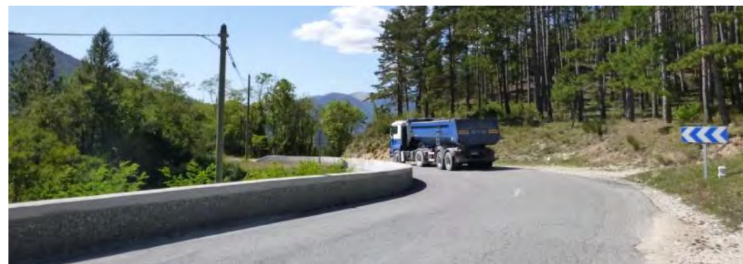
Exemple de murette servant ici de glissière de sécurité, à installer côté relief
