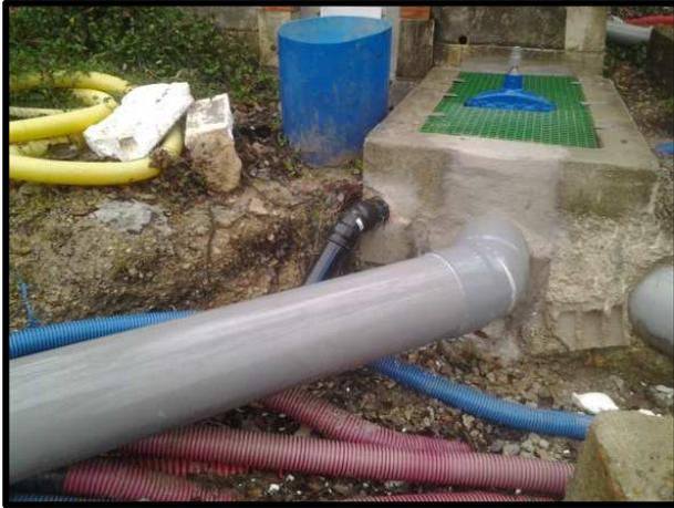
**Photo 2 (BG.Consultant 2014)** : sortie du captage bas (PVC à gauche : sortie actuelle, PVC central : sortie vers bache de mélange, PE noir : trop plein)
