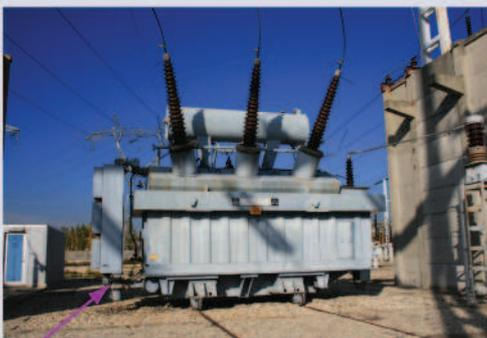
**Les transformateurs** sont des appareils qui modifient la tension électrique à la baisse (par exemple de 225 000 volts à 63 000 volts).
