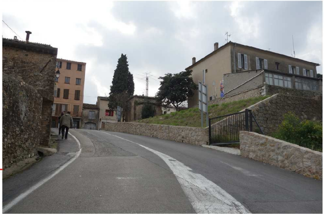
La placette du transformateur
