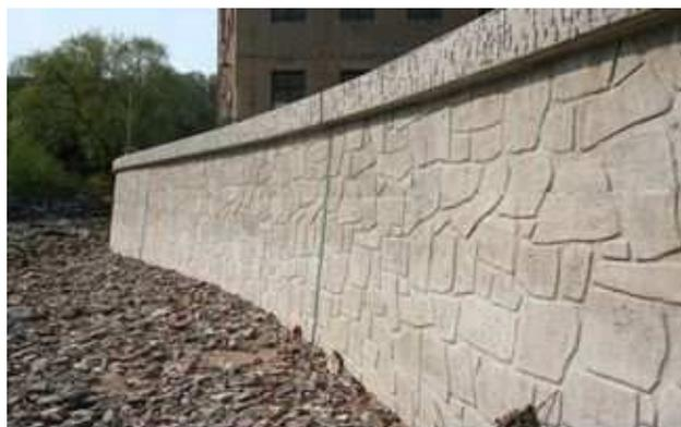
Figure 5 : aspect mur béton matricé
