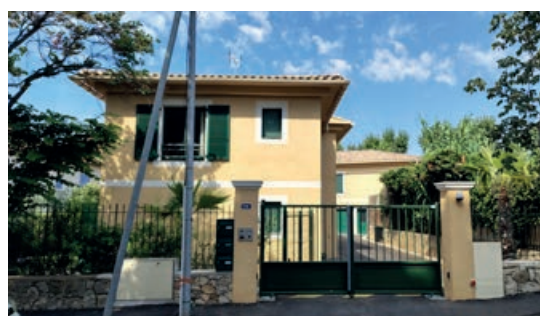
Rue Michelet , bâtis construits en 2024 sous la forme de trois logements en R+1, avec accès en commun.
