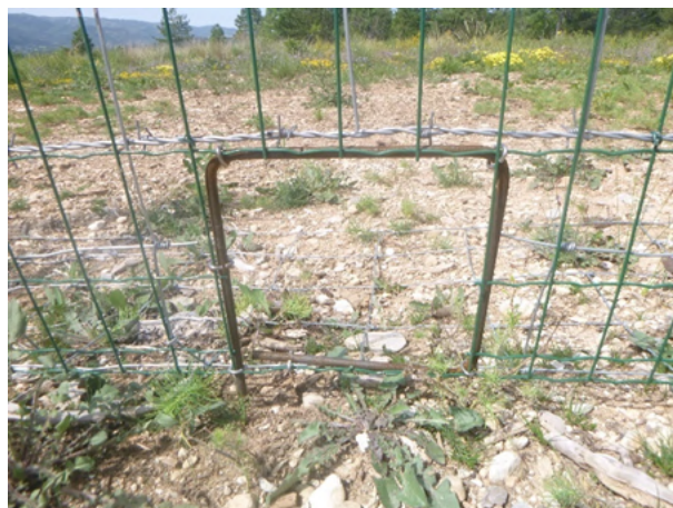
Exemple de passage à faune sur le parc photovoltaïque de Dignes-les-Bains (04), d'environ 20X20cm
