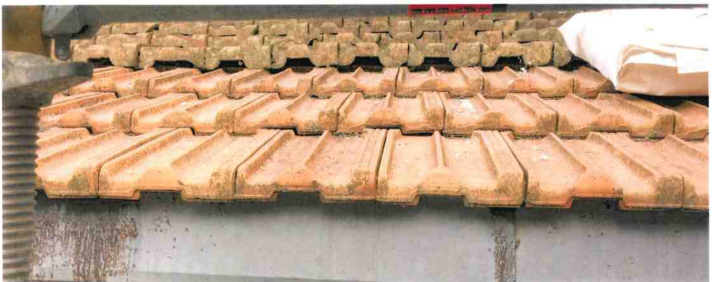
Tuiles de différents modèles avec défaut d'emboitement.
