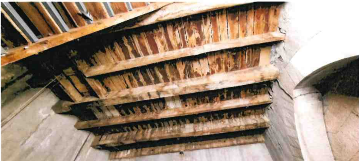
Désordre sur toiture de part et d'autre du clocher
