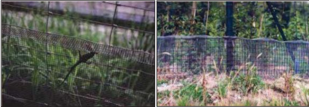
Exemples de clôtures à petites mailles dont la partie supérieure est inclinée et dont la partie inférieure est enterrée. Les clôtures en question sont plaquées sur une clôture classique.
