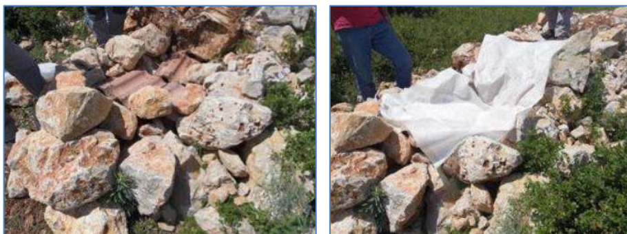
Figure 90 : Pose des pierres et géotextiles sur les tuiles (@Crerco – Pauline Demonfaucon, juillet 2017)
