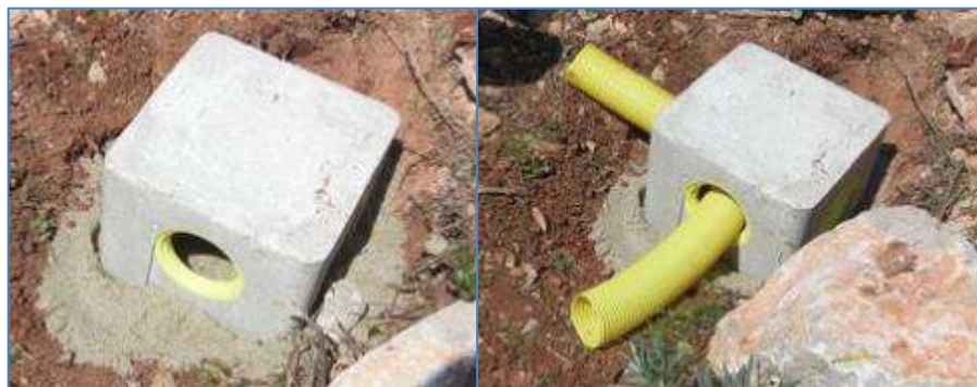
Figure 88 : Mise en place du caisson et des gaines (@Crerco – Pauline Demonfaucon, juillet 2017)
