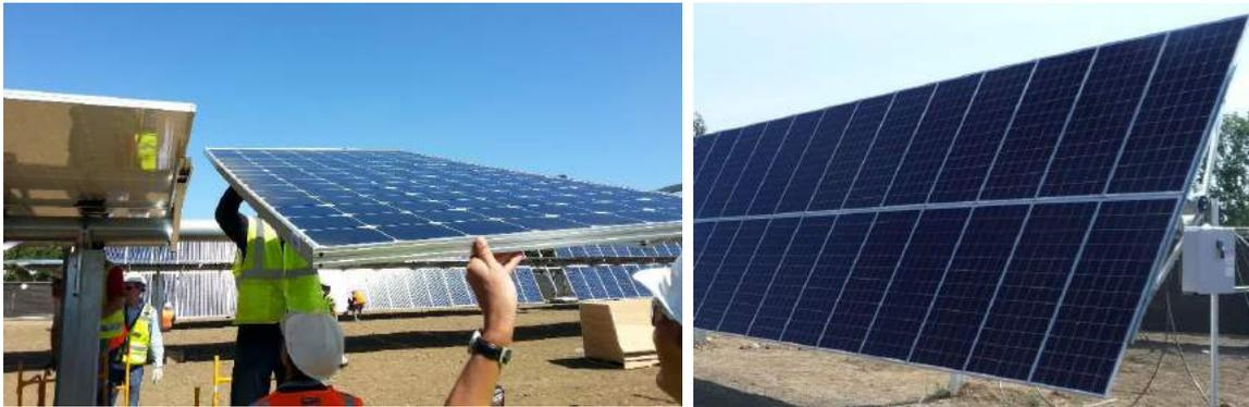
**Photographie 2-5 : Mise en place des panneaux photovoltaïques**
