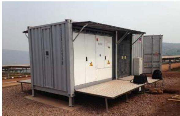
**Photographie 16 : Exemple de plateforme onduleur**
