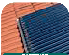
CAPTEURS THERMIQUES TUBES SOUS VIDE intégration délicate
