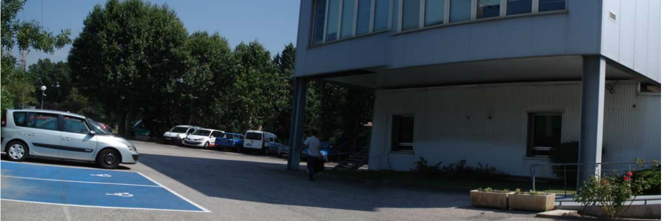
Figure 10: Bâtiment principal L1 vue sur la partie Est depuis la bordure Nord du site
