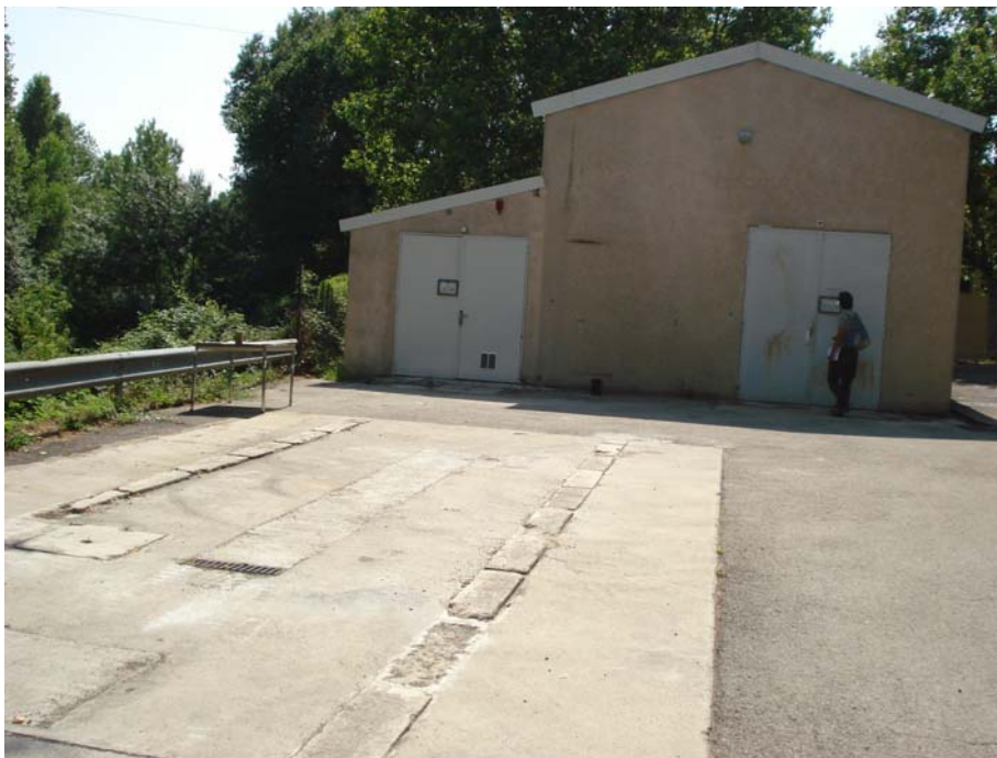
Figure 35 : Vue sur l'ancienne aire de sablage et le bâtiment E2
