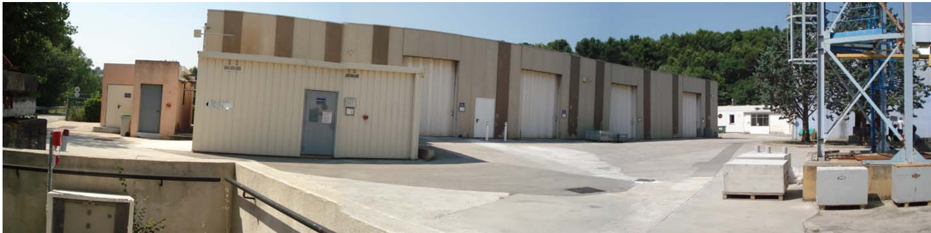
Figure 13: Vue sur l'atelier At
