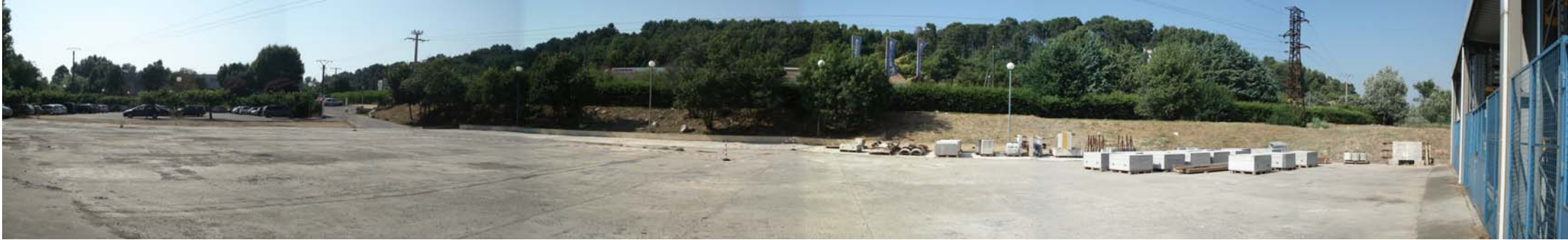
Figure 2: vue panoramique de la zone A avec le parking véhicule à l'Ouest, la surface de stockage en dalle béton et l'entrepôt (E1) à l'Est
