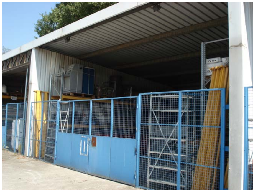
Figure 4 : Vue de l'entrepôt E1
