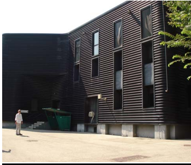
Figure 29 : Façade Sud du bâtiment L2 (laboratoires d'essai)
