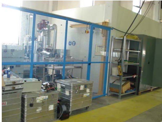
Figure 32 : Détail de l'intérieur du bâtiment L2 – partie entrepôt
