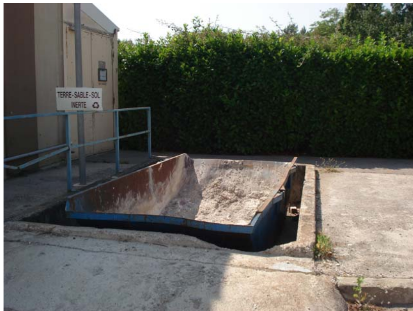
Figure 17 : Benne de stockage de terre, sable et sol inerte en bordure de l'atelier At
