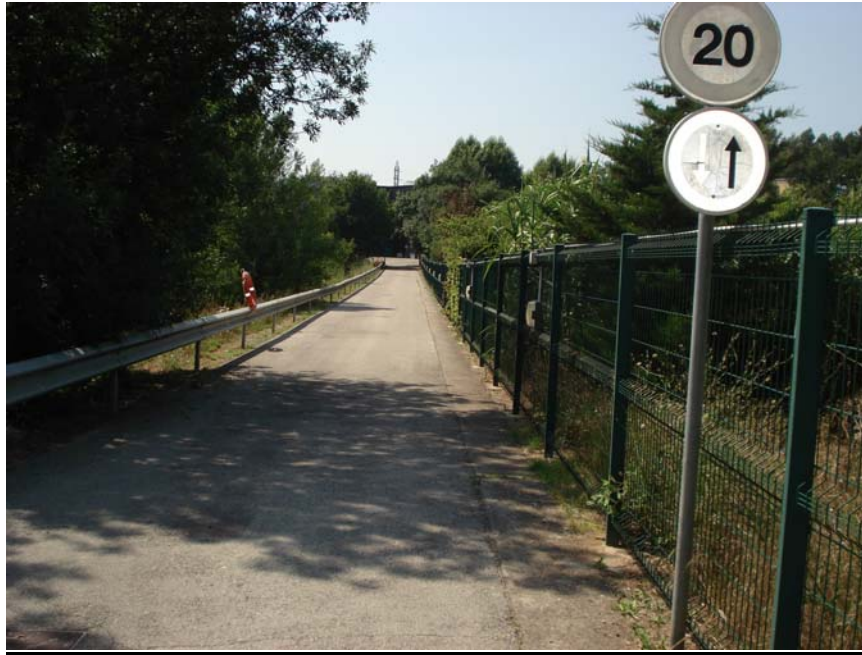
Figure 27 : Chemin d'accès à la zone D
