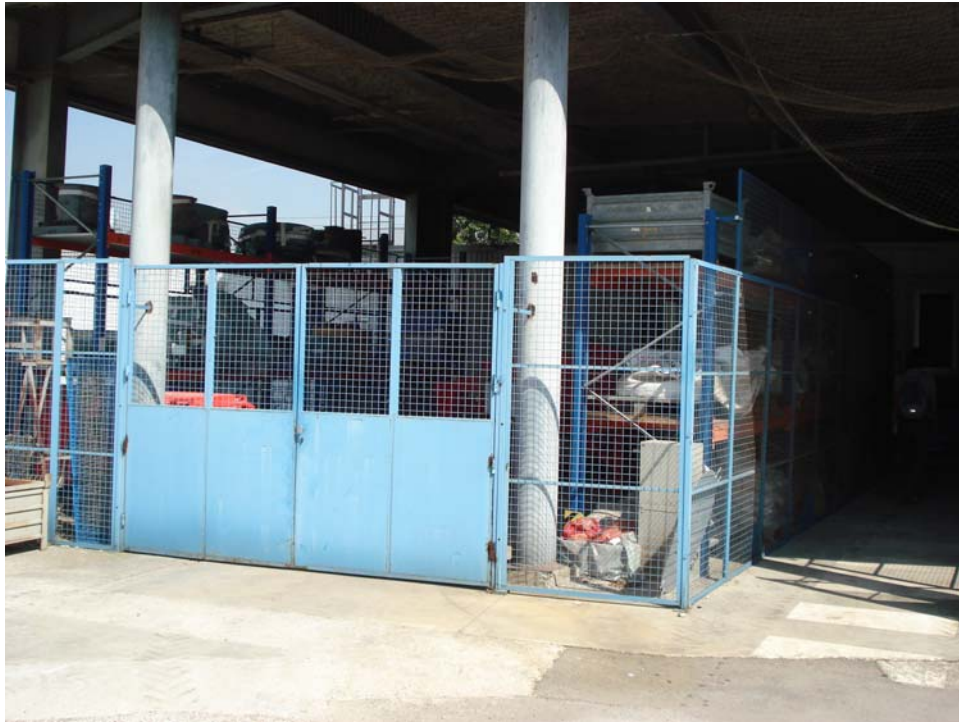
Figure 21 : Zone de stockage de petit matériel abritée à l'extrémité de l'aile Sud Ouest du bâtiment principal
