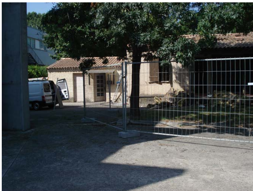
Figure 14: Vues sur le local Lo1 en cours de réaménagement
