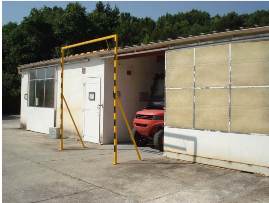
Figure 19 : Emplacement de la cuve à fioul n°1 dans le bâtiment principal (aile Nord Ouest)
