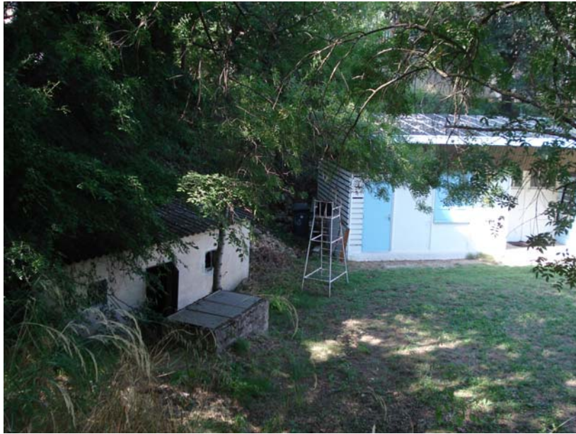
Figure 26 : Bâtiment du club house et bâtiment annexe associé
