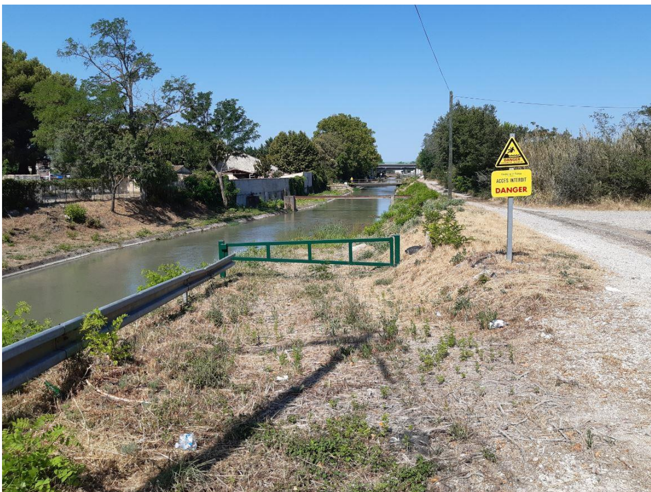
Figure 20 : Prise de vue de la rampe d'accès existante « R2 » (Source : EDF)
