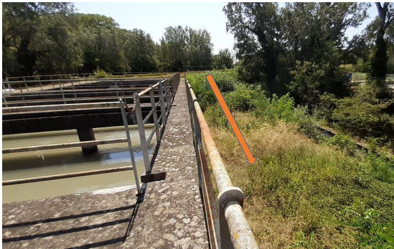
Figure 24 : Accès aux ouvrages du partiteur de Noves (Source : GOOGLE EARTH)
