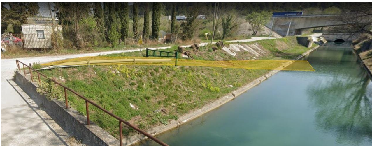
Figure 19 : Prise de vue de la rampe d'accès potentielle « R1 » (Source : GOOGLE EARTH)
