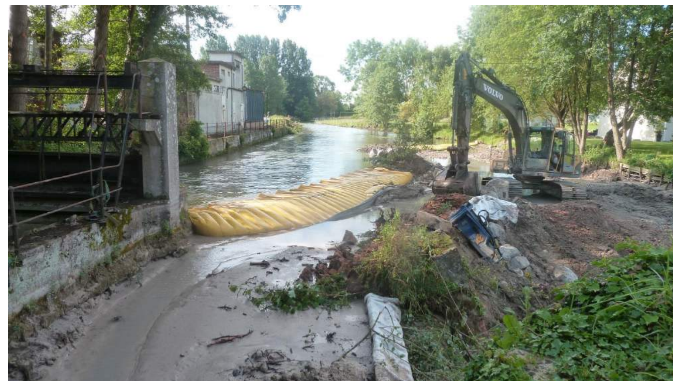
Figure 46. Illustration du dispositif de type Watergate permettant de réaliser une mise au sec des zones de travaux
