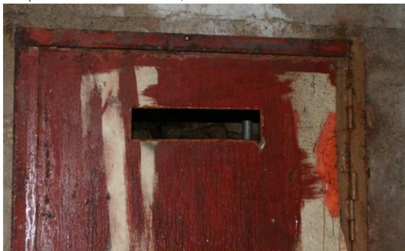
Exemple de porte découpée (ouverture type boîte aux lettres (environ 7-8 cm x 40 cm à environ 1,6 m de hauteur) - Source : SFEPM
