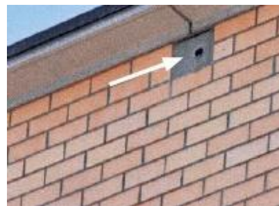
Nichoir intégré au bâti - Source : Sites de nidification pour les Martinets noirs et à ventre blanc - Iris Scholl
