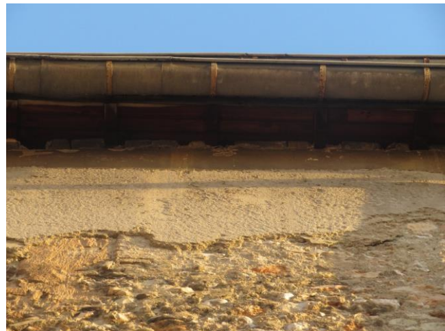
Exemple de fissure utilisée par le Martinet noir sur un bâtiment niçois Photos prises en dehors de la zone d'étude – ECOTER 2021
