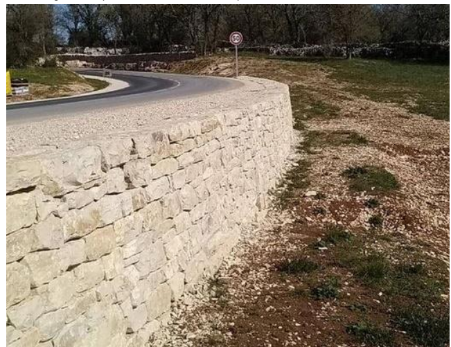
Mur en pierre sèche Source : La Dépêche- Syndicat mixte du Grand Site de Rocamadour
