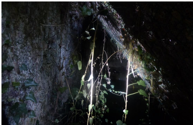
Bassin de régulation souterrain favorable au gîte de transit ou hivernal Photo prise dans la zone d'étude – ECOTER, 2022
