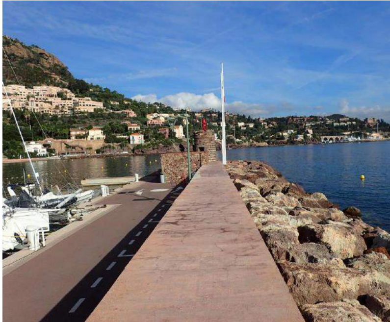
Figure 16 : Photo n°1 – Digue de protection - ICTP septembre 2019
