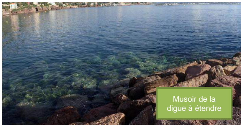
Figure 18 : Photo n°3 – Pied du musoir - ICTP septembre 2019
