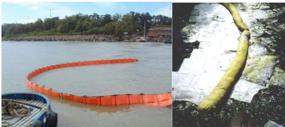
Figure 86 : Installation d'un barrage flottant / Barrage absorbant ( http://www.flexitankchina.fr ) / ( cedre.fr )
