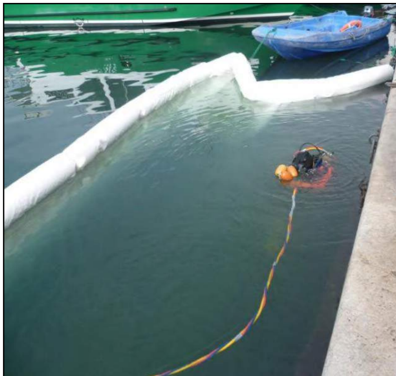
Figure 85 : Utilisation d'un filet anti-MES similaire lors des travaux de réhabilitation des quais du port de Saint-Tropez - (ICTP / 2011)
