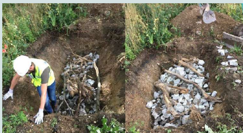
Figure 124 - Exemple de remplissage d'un hibernaculum (Egis)
