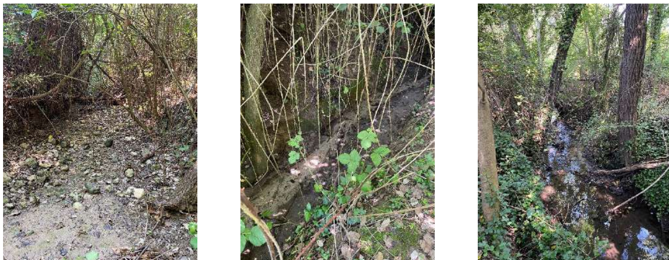
Figure 70 : Le Budéou à l'emplacement du futur ouvrage d'art ; Source d'alimentation en eau du Budéou en rive droite ; Diversité d'écoulement visible en aval de la zone de travaux
