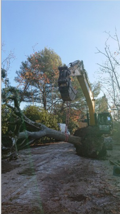
Déterrage et transport d'un platane
