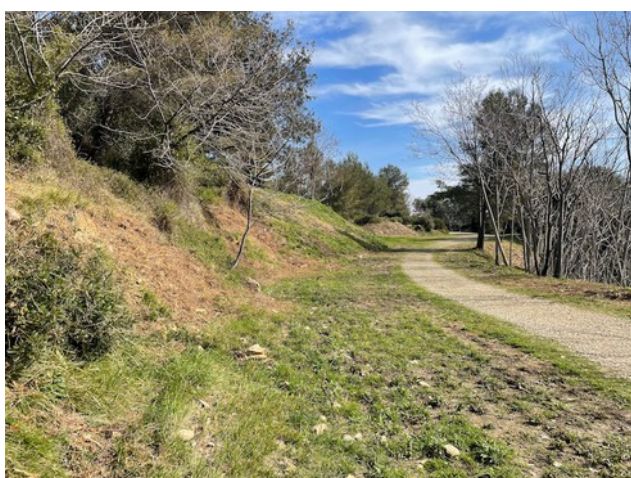
Au niveau de l'entrée haute, possibilité de création d'un muret de soutènement pour stabilisation du talus
