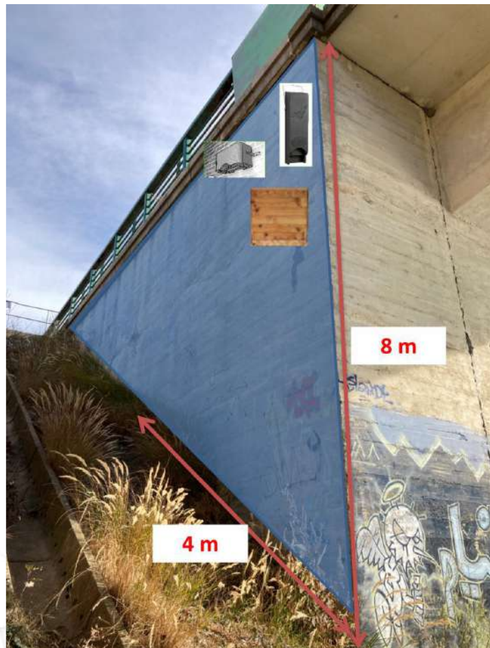
Figure 81 : Proposition d'installation de nichoirs sur le pont Riou Bourdou, face NORD de la culée. Les flèches rouges représentent les dimensions du pont. La bande bleue représente la zone envisagée pour l'installation de 3 nichoirs.
