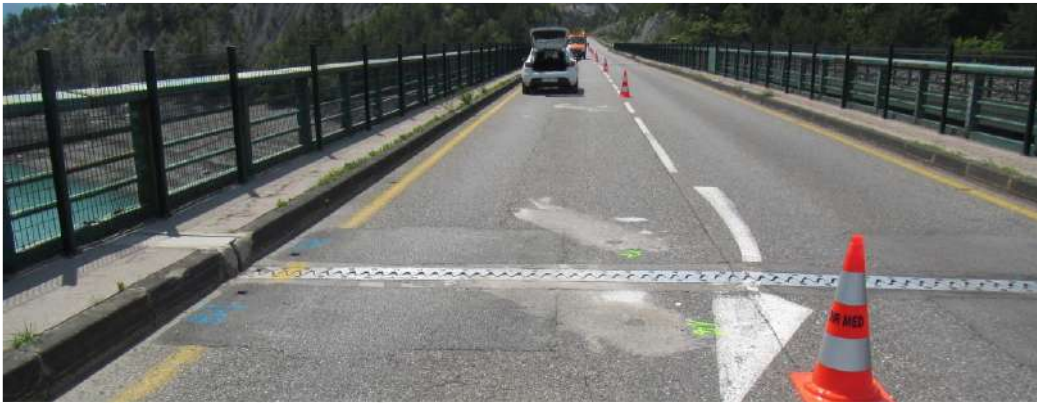
Figure 9 : Photographie du dessus du tablier.
