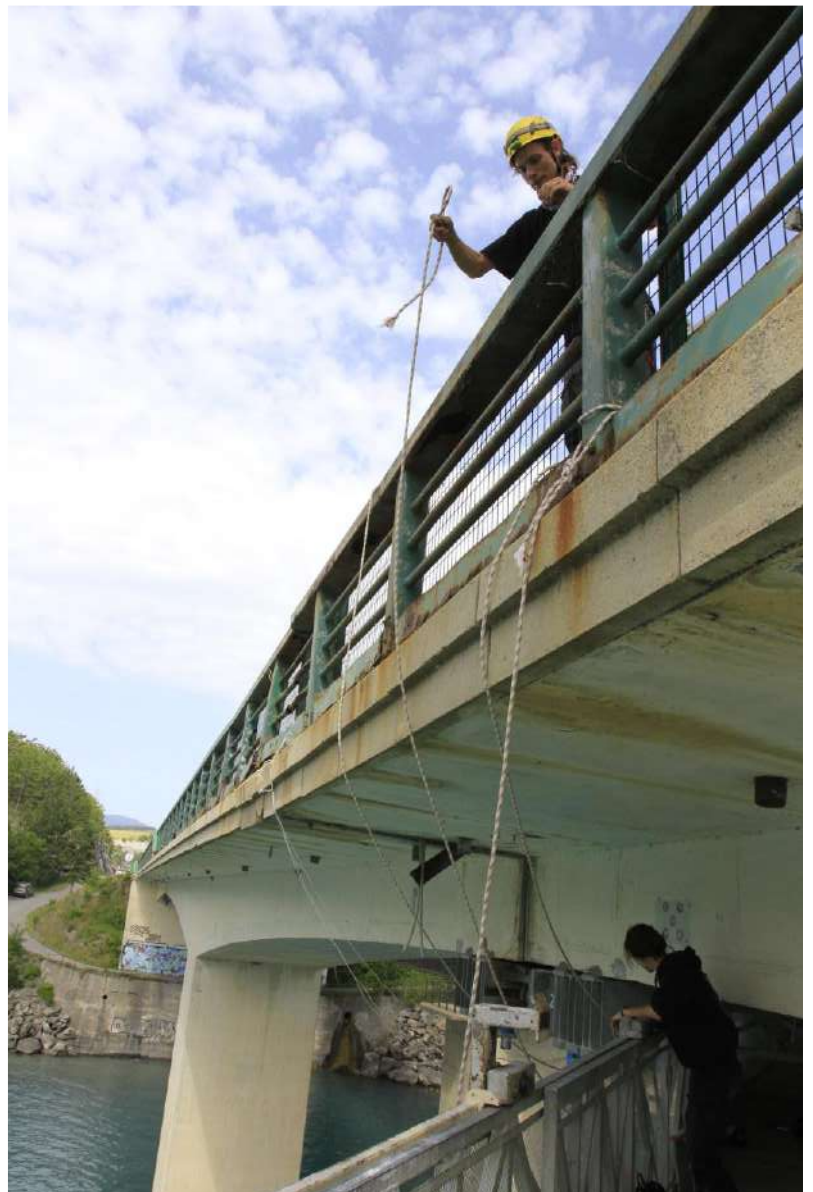
Photo 2 : Équipement de l'accès corde. Photo : GCP
