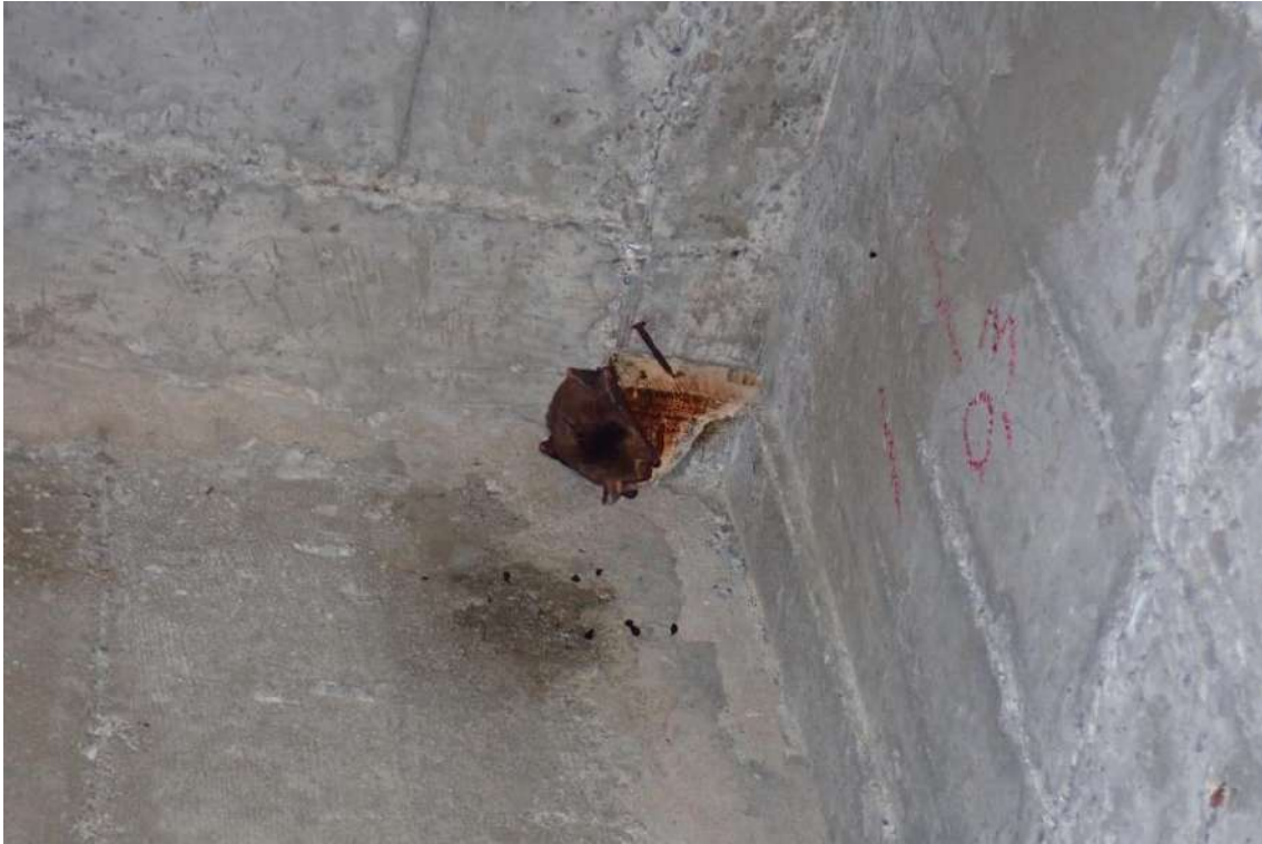
Photographie 5 : Petit ou Grand Murin dans un caisson du pont de Riou Bourdou. © Jean Caroline (GCP), 2021
