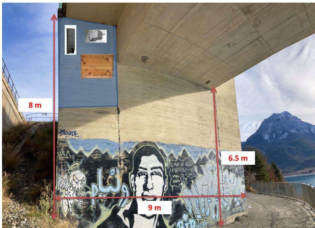
Figure 22 : Proposition d'installation de 3 nichoirs sur le pont Riou Bourdou, face intérieure de la culée Est et Ouest. Les flèches rouges représentent les dimensions du pont. La bande bleue représente la zone envisagée pour l'installation de 3 nichoirs.
