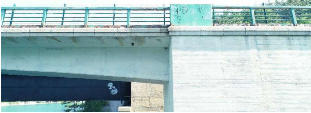
Figure 8 : Photographie de la culée côté Briançon.
