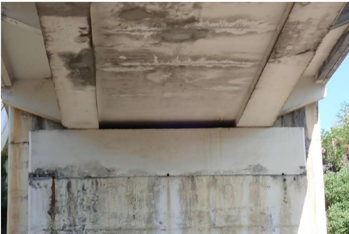
Photographie 18 : Espace sous le pont abritant le Gîte 4. © Jean Caroline (GCP), 2021
