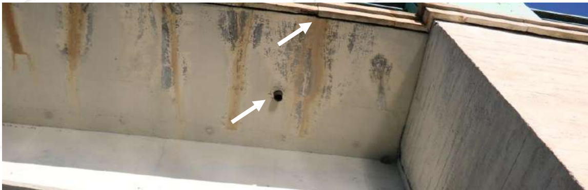
Figure 10 : Photographie de la corniche et système d'évacuation des eaux. GCP, 2021.
