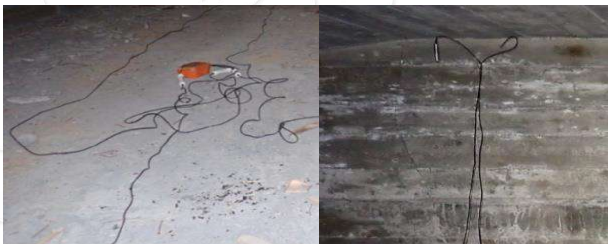
Figure 35 : Sondes installées dans le pont, à droite le boîtier HOBO et à gauche les sondes du HOBO.
