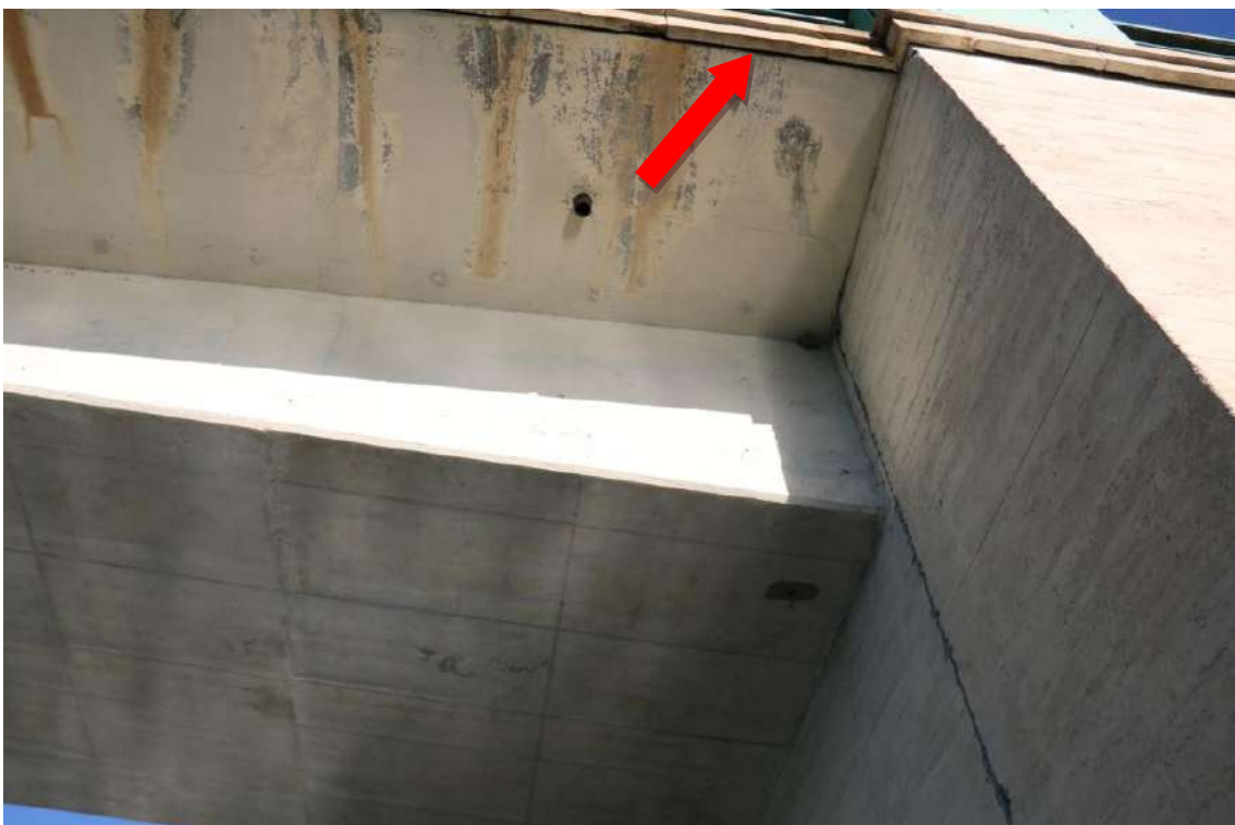
Photographie 13 : Corniche dans laquelle les chauves-souris peuvent s'abriter (la corniche est indiquée par la flèche rouge). © Jean Caroline (GCP), 2020
