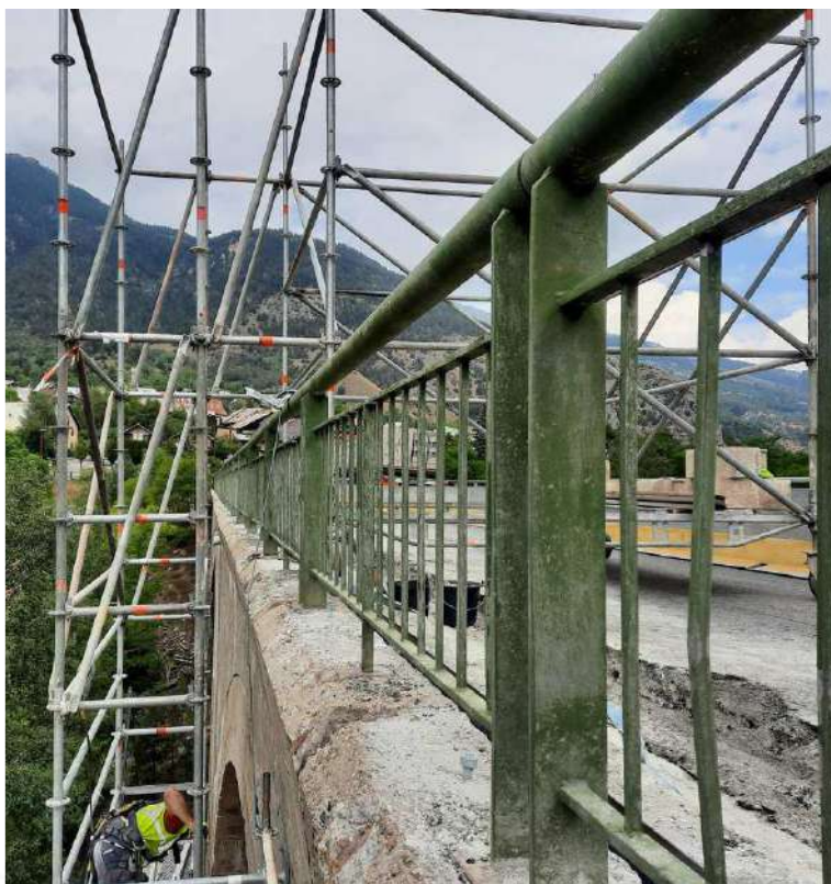
Figure 72 : Exemple échafaudage roulant sur chantier.
