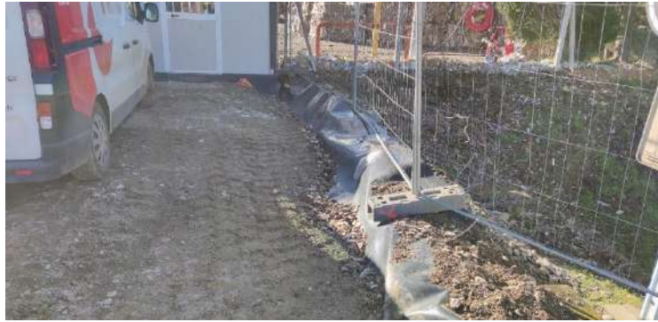
Figure 78 : Exemple d'aire étanche.
