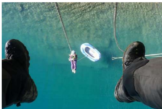
Figure 7 : Vue depuis un caisson du pont Riou bourdou de l'accès corde depuis le bateau - © GCP
