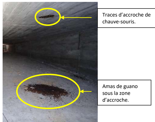
Figure 15 : Indice de présence indirecte de présence de Chiroptères dans un caisson du pont de Riou Bourdou - © GCP
