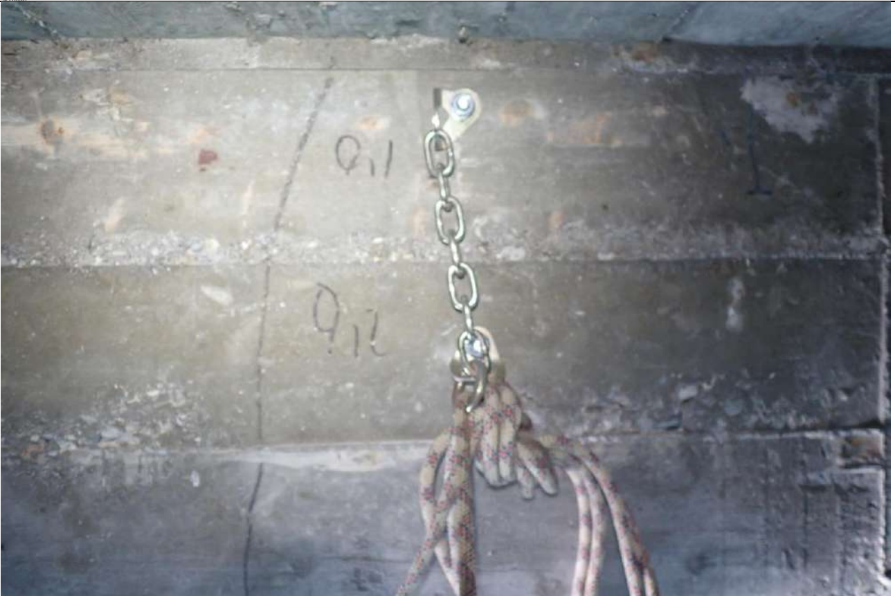
Illustration 5: ancrage caisson accès permanent
