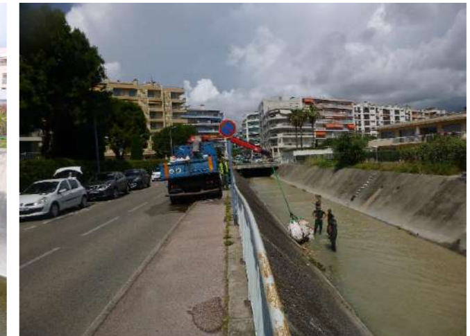
Opération de curage des sédiments contenant de la Jussie à grandes fleurs - ©P. AUDA
