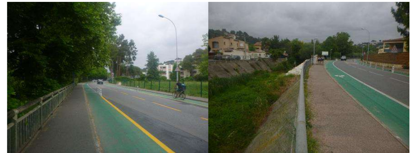
Revégétalisation sur 6 m en bordure de Cagne (secteur 1) 1
