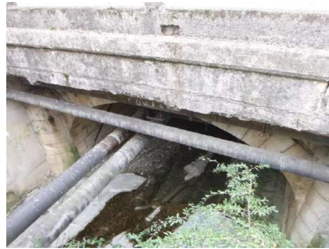
Cours d'eau canalisé (Vallon des Vaux), avec ouverture ponctuelle, adjacente au passage souterrain - ©P. AUDA
