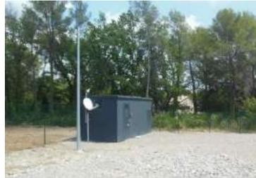
Des éléments permettant de suivre la production et de sécuriser le site pourront être implantés sur le poste de livraison : station météo, antenne satellite...
