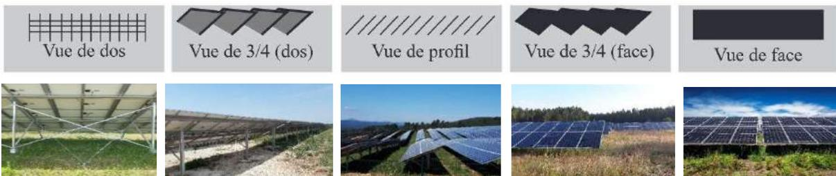
L'installation des châssis sur pieux avec un enfoncement déterminé en fonction de la topographie a l'avantage de préserver la structure du site. Ainsi les rangées de châssis suivront parfaitement les lignes du relief.
