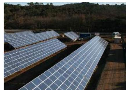
Les caractéristiques du site et la hauteur des modules déterminent, entre autres, l'intervalle nécessaire entre les rangées de modules. Cette distance permettra la circulation des véhicules de chantier, de maintenance et des services de secours incendie. Pour le projet de La Bâtie- Montsaléon, la distance inter-rangée est de minimum 3,50 m pour les rangées supérieures à 200 m, sinon l'espace inter-rangée sera au minimum de 2 m.
