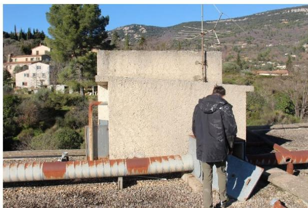
Photographie 5. Emplacement du local avec le ballon d'eau chaude sur le toit R+5 où loge une colonie. © Emmanuel COSSON (GCP), 2025.
