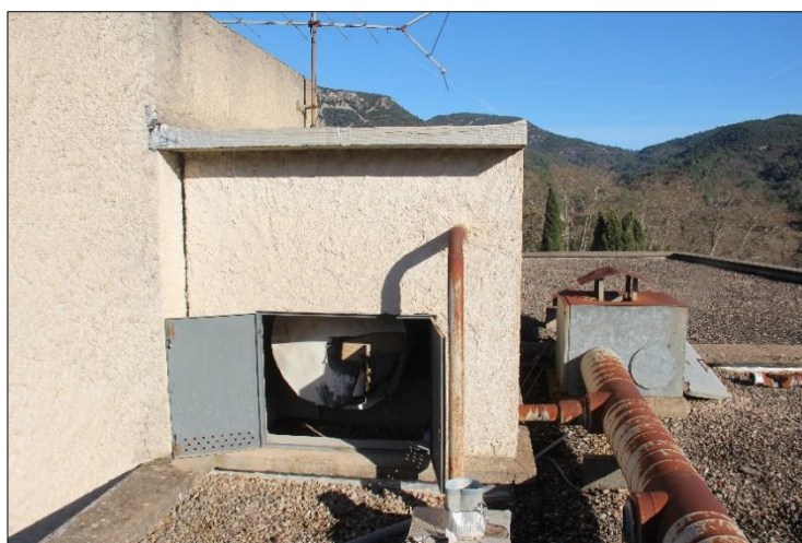
Figure 25: Photographies local chauffe-eau abritant la colonie de Petit Rhinolophe, situé sur le toit du bâtiment (Source : GCP, 2025)
