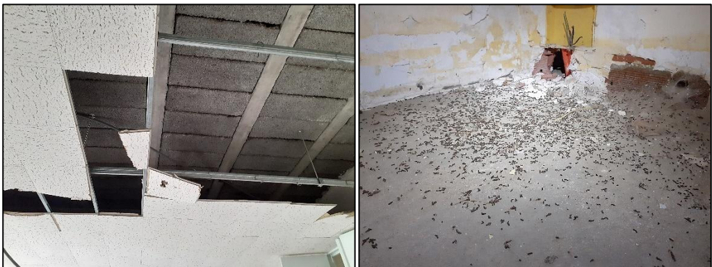
Figure 27 : Photographies de faux plafonds du réfectoire (rdc), favorables au gîte des chiroptères (à gauche), et de guano constaté dans une pièce d’un appartement (droite) (Source : SEGED, 2024)
