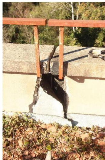
Photographie 9. Joint entre le solin du toit terrasse R+4 et le joint de dilatation en façade Nord de l'aile Est non étanche et avec présence de guano. © Emmanuel COSSON (GCP), 2025.
