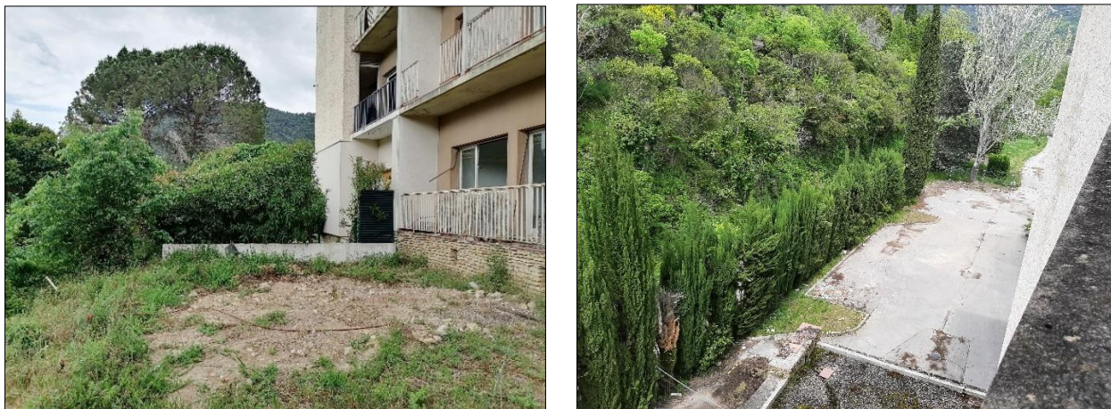
Figure 22 : Haie de Laurier rose et végétation herbacée (façade Sud-est du bâtiment) – à gauche ; Alignement de Cyprès (façade Nord du bâtiment, le long du chemin de San Peyre) – à droite.
