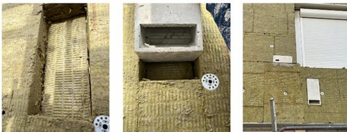
Figure 35: Photographies de réserve dans l'isolant avec coupure isolante pour intégration de gîte à chiroptères, site pilote d'Orly
