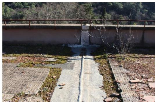
Photographie 11. Solin du toit terrasse en R+4 (aile Est) côté Sud. © Emmanuel COSSON (GCP), 2025.
