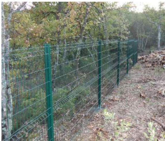
Exemple de clôture– Parc solaire de Montmayon
