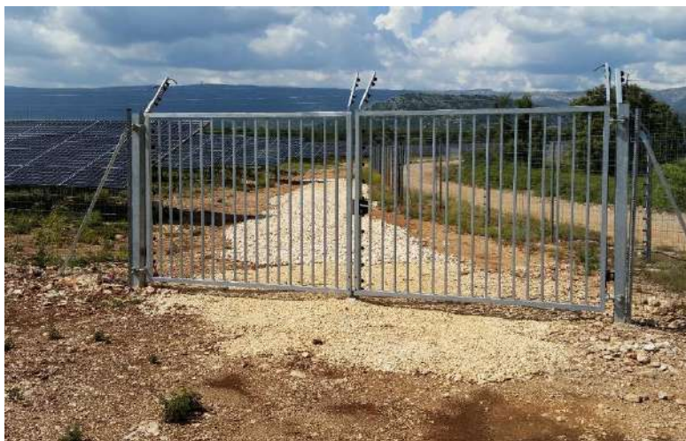
Exemple de portail à battant- Parc solaire de Castellet
