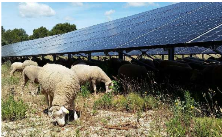
Exemple de pastoralisme sur le parc solaire du Castellet
