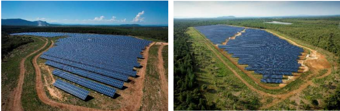
Centrale solaire de Belvesol dans le Gard (20 MWc)
