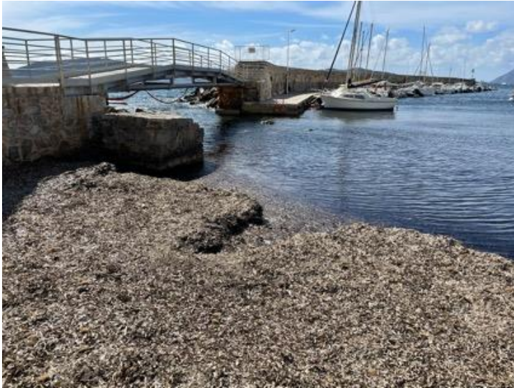
Figure 16 : Frondes mortes émergées et immergées, et connection avec l'extérieur
