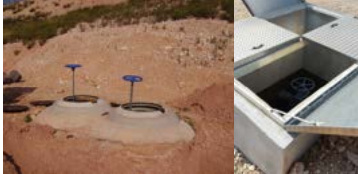
Chambre d'accès des vannes gravitaires des bassins B2 et B3
