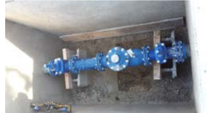
Mise en place de disconnecteurs
