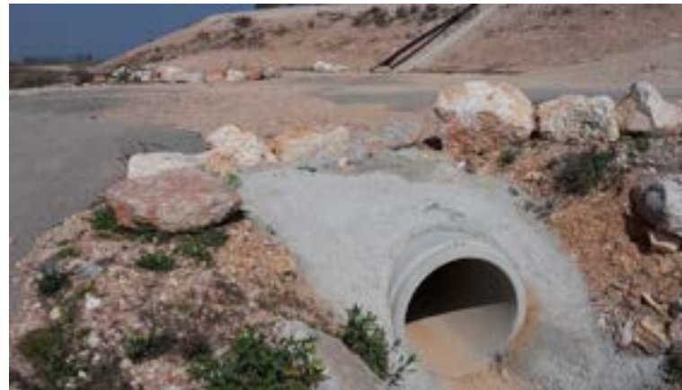
Changement de la buse d'évacuation des Eaux pluviales
