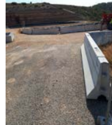
Glissières de protection des bassins de lixiviats
