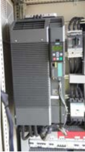
Changement du variateur du système de pompage des lixiviats
