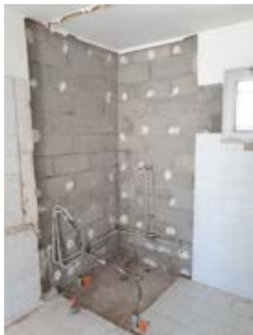
Travaux de remise à niveaux des locaux du personnel
