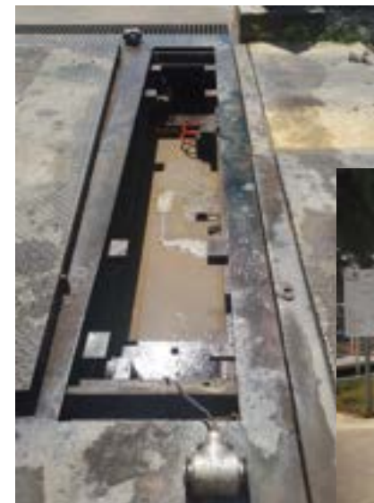
Maintenance des ponts bascule et pose de répéteur
