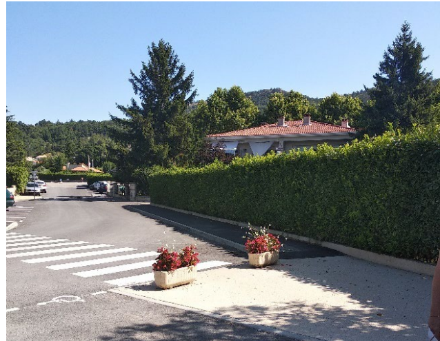
A Volonne, l'objectif a été de limiter l'utilisation des potelets et de trouver d'autres techniques (exemple : pots de fleurs) pour protéger les alentours de la Maison de Santé.
