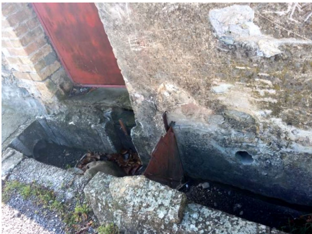
A Volonne, le projet de centre-bourg a intégré les anciens canaux d'irrigation qui n'avaient plus d'usage pour l'agriculture, pour les convertir en réseau de collecte des eaux pluviales.
