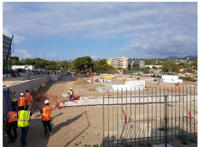
Pour le quartier Méridia à Nice, un bassin de rétention souterrain associé à un espace végétalisé en creux (en construction) tamponnera une partie des eaux d'orages du quartier.
