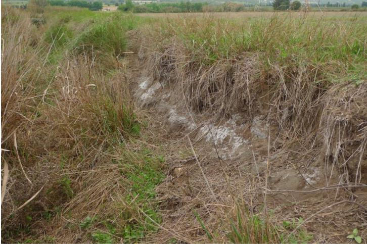
Figure 18 : Sel cristallisé sur les franges de canal à sec
