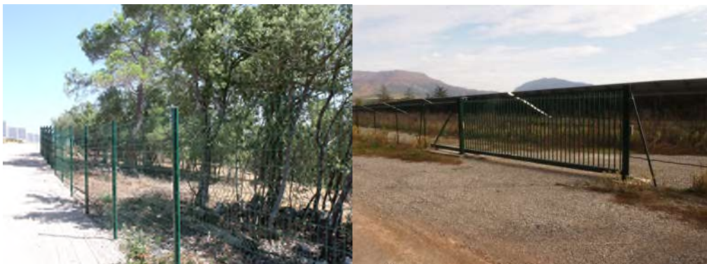
Figure 11 : Exemple de clôture et de portail coulissant ©Engie Green
