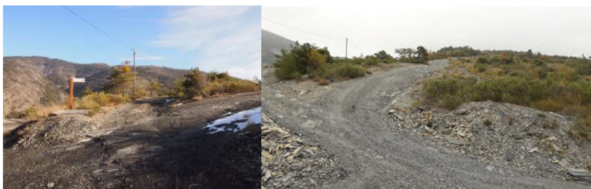
Figure 3 : Piste existante depuis la RD 1 au nord
