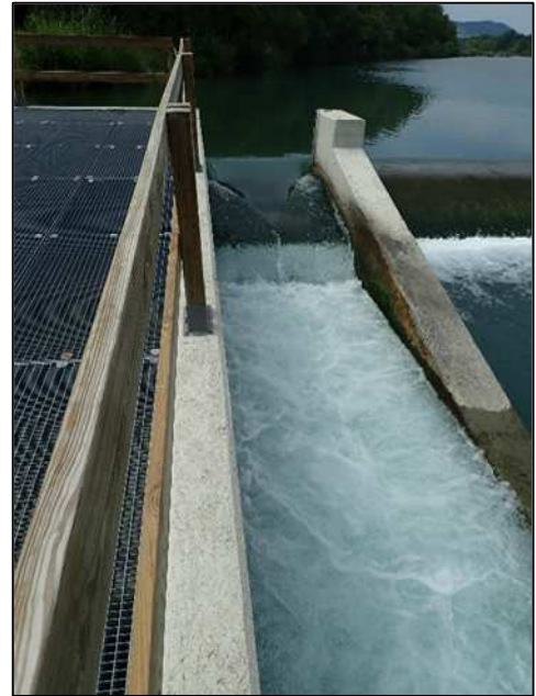
Photographie 10 : Echancrure sur le seuil à côté de la passe à apron
