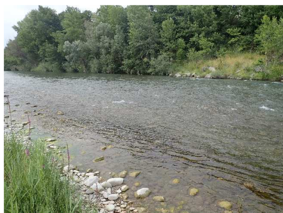
Photographie 1 : Radier amont (juillet 2020)
