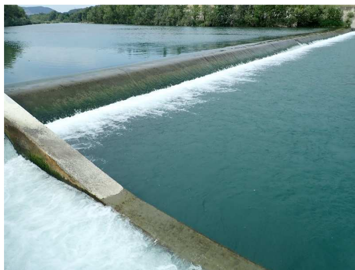
Photographie 9 : Seuil de Salignac, radier et passe à apron en rive droite (juillet 2020)
