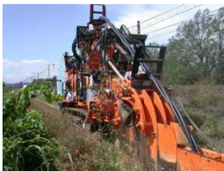
Figure 16 – Photo de chantier associé à la pose des câbles pour le raccordement (source : ENGIE PV Sablière du Grand Vallon)
