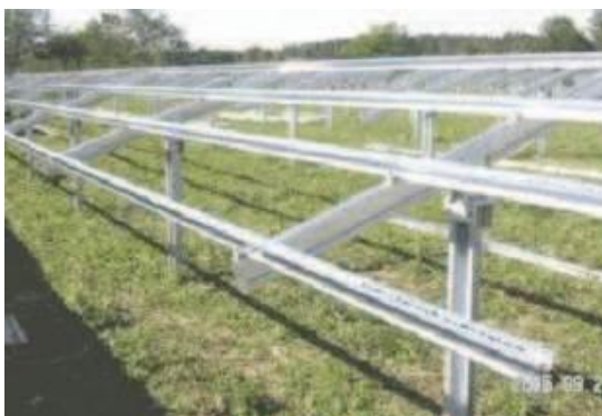
Figure 13 - Structures fixes avant installation des modules (source : SchletterGmbH)
