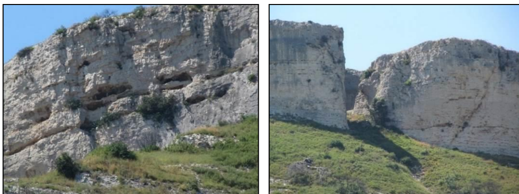
Figure 31 : Falaises à l'ouest de la zone d'étude pouvant accueillir des chiroptères en gîte (J. PRZYBILSKI, 17/06/15, Sénas)
