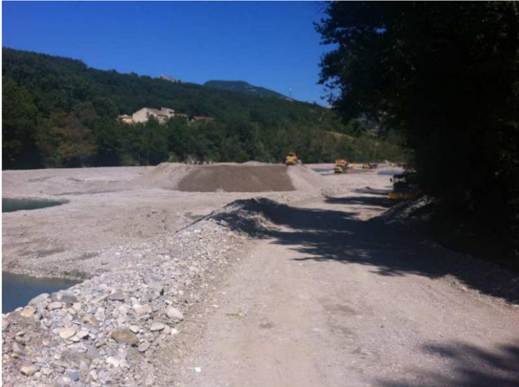
Figure 4 : Piste d'accès dans le piège à graviers (source : EDF)
