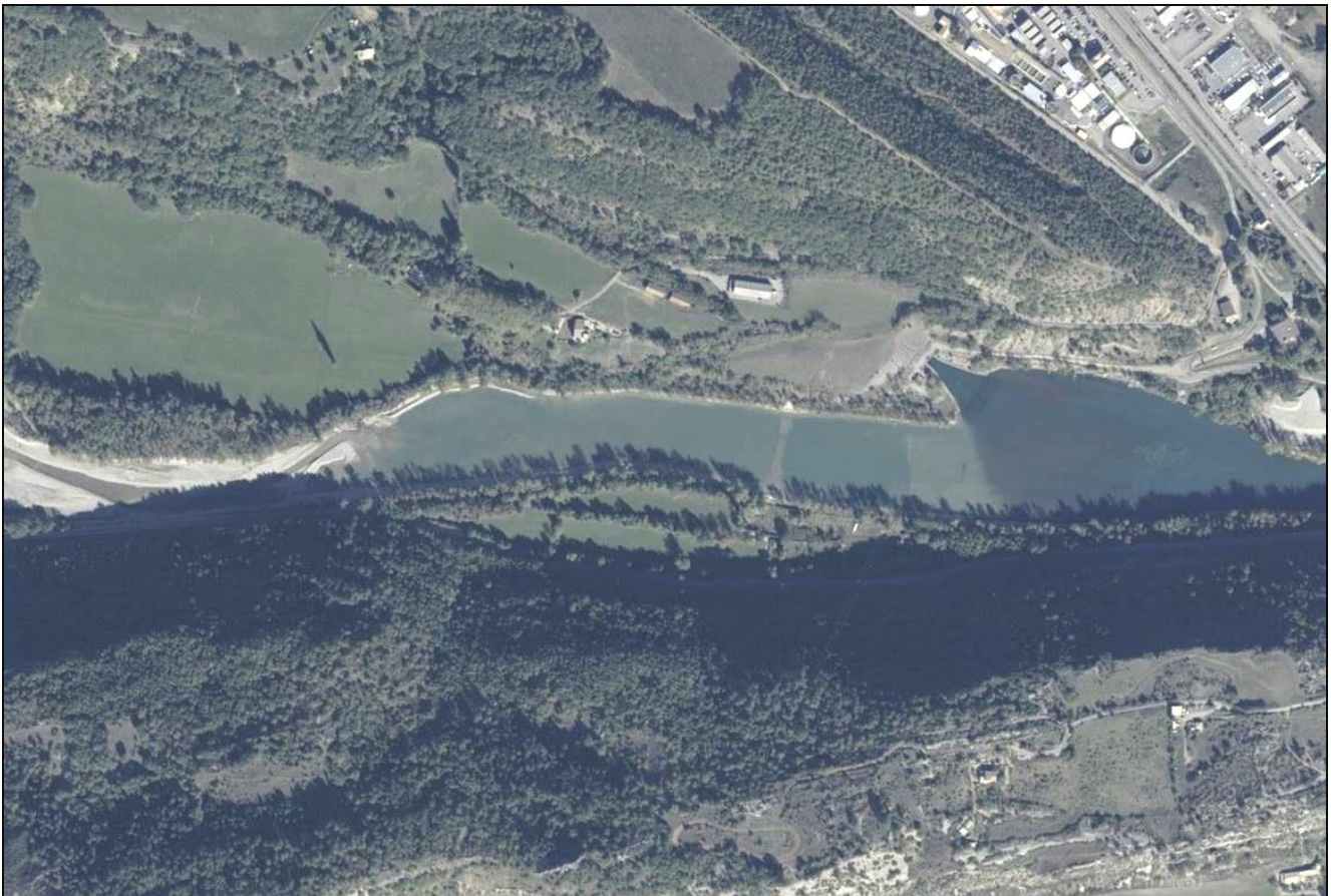
Figure 16 : Orthophoto prise le 16/10/2012 après curage (source : IGN)
