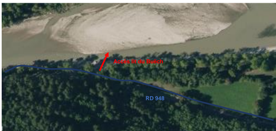
Figure 3 : Accès au piège à graviers existants (source : EDF)
