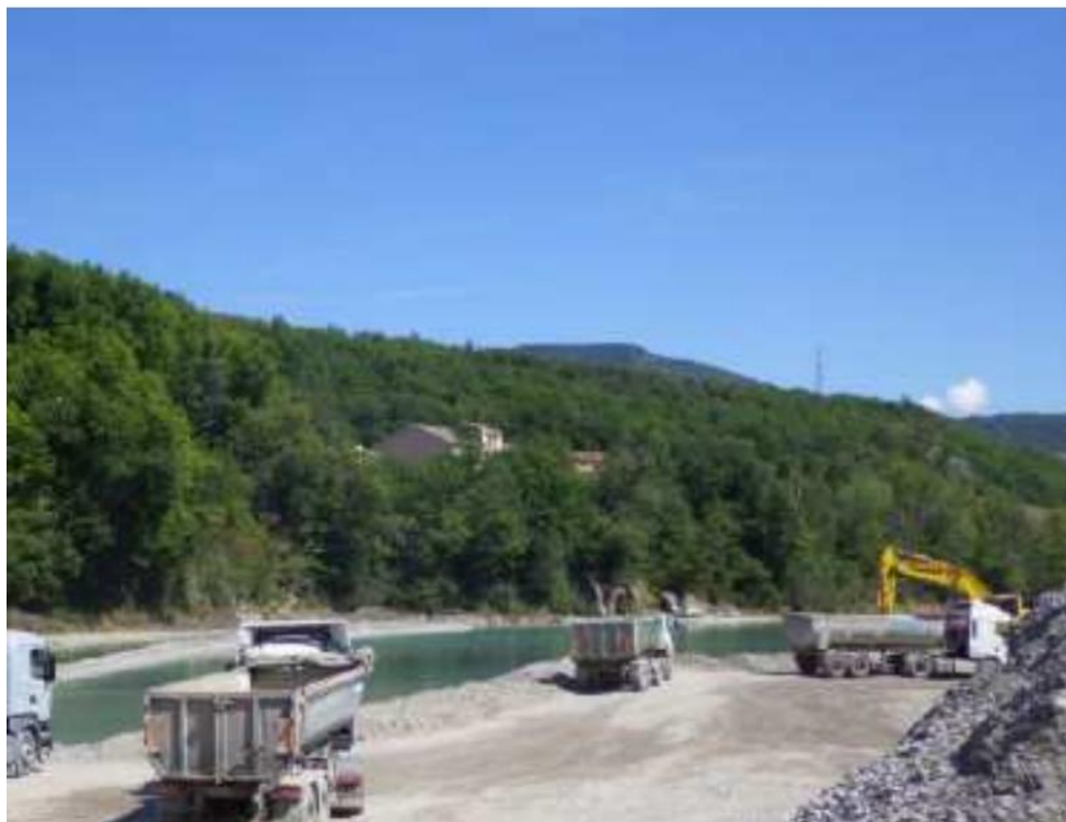
Figure 5 : Photographie du chargement et évacuation du stock de sédiments lors du curage du Buëch en 2017 (source : EDF)
