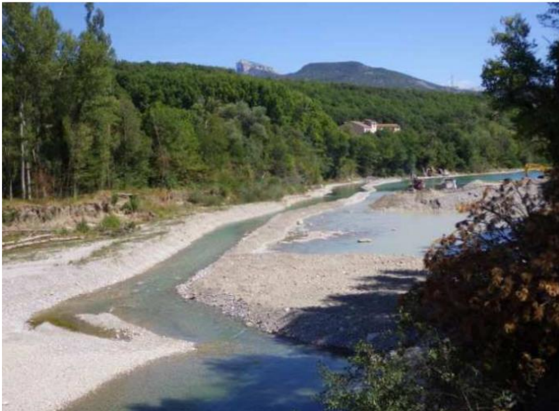
Figure 6 : Photographie de la chenalisation du Buëch en rive gauche lors du curage de 2017
