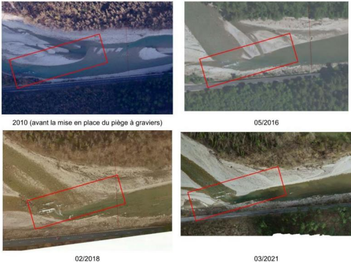
Figure 2 : Evolution de l'affleurement rocheux avant (photo 2010) et après mise en place du piège à graviers (photos 2016, 2018 et 2021) (Source : Dossier d'exécution, EDF, 2022)
