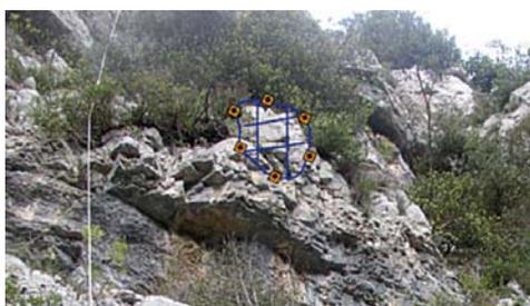
**Caractéristique du confortement :** purge + confortement par mise en place d'un filet de câble plaqué de 2,5 x 3 mètres, tendu par un câble de rive de diamètre 16 mm.
