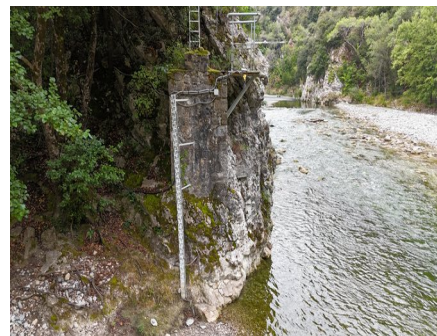
Station du Broc sur l'Estéron (06) (Source : DREAL PACA)
