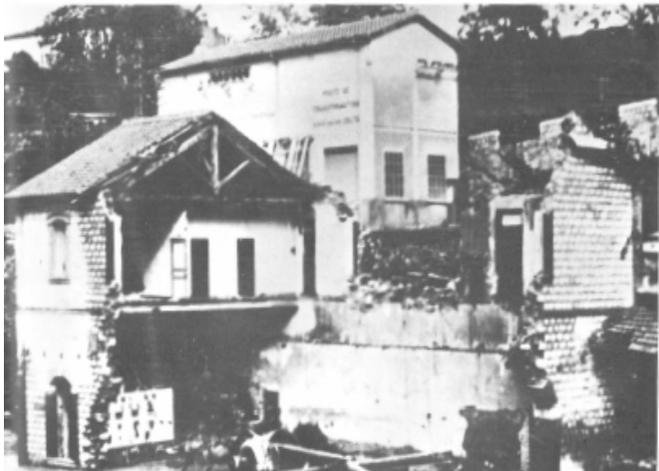
*Une usine hydro-électrique dans la vallée du Tech, détruite par un torrent et qui, après avoir résisté, a fini par céder, libérant soudainement une vague destructrice en aval.*
