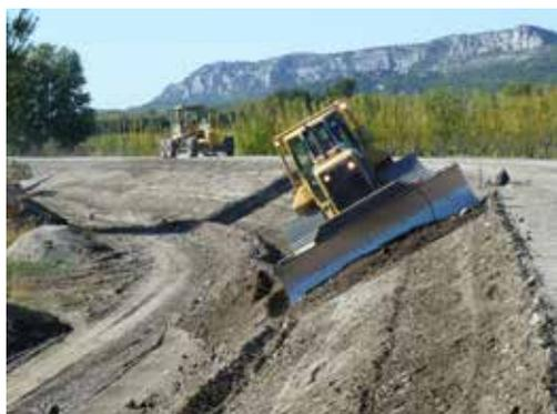
« Le cliché a été réalisé durant les travaux de restructuration de la digue des Royères à Charleval (13). Ce chantier fait partie des opérations successives de restructuration d'un système de protection intercommunal déployé sur plus de 15 km du cours de la Durance et sur ses deux rives.
