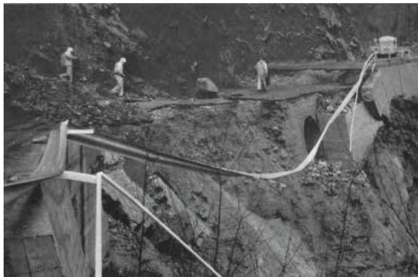
*Amélie-les-Bains – Palalda. Le pont de chemin de fer après la crue. Les rails boulonnés aux traverses restent suspendus dans le vide.*
