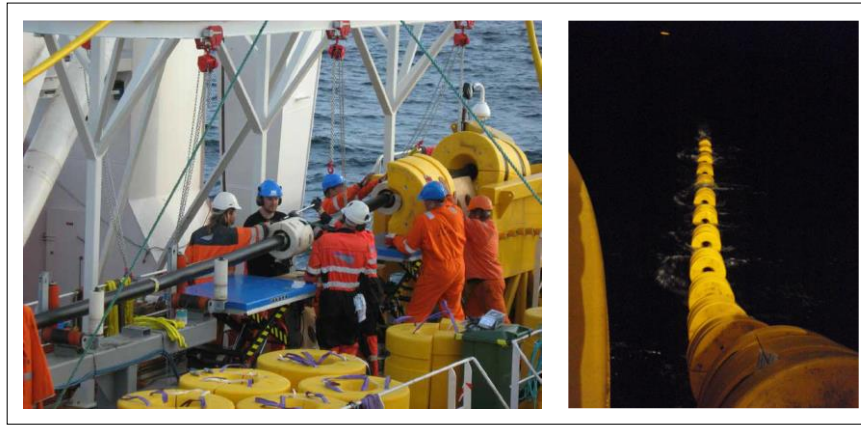
Figure 3-21 : Installation des bouées (PEOPGL, 2017)
