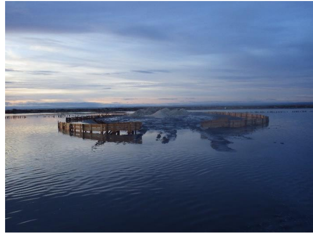
Figure 9-6 : Création de l'îlot du bassin ouest sur l'ancien salin de Villeroy
