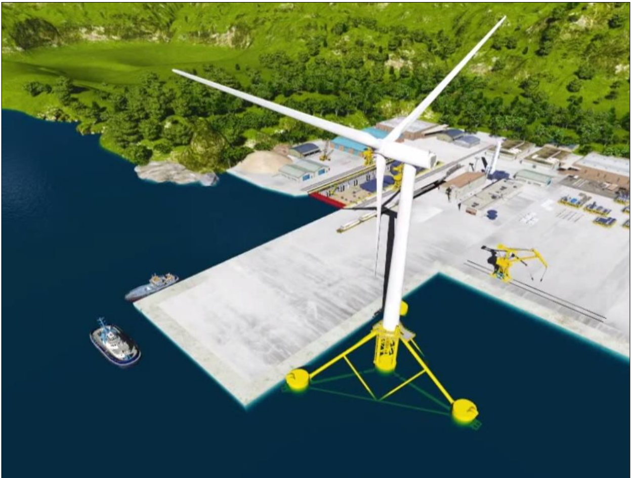
Figure 3-12 : Illustration de l'éolienne montée sur le flotteur bord à quai (© SBM Offshore dans PEOPGL, 2017)
