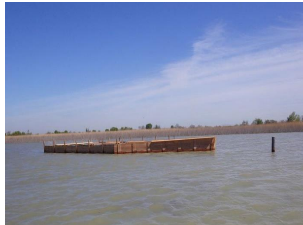
Figure 9-8 : Mise en place de deux radeaux flottants destinés au Marais du Vigueirat et à la Poudrerie royale de Saint-Chamas et Miramas.
