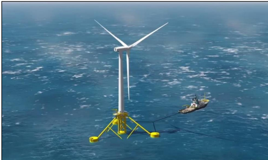
Figure 3-15 : Vue artistique du remorquage de l'éolienne flottante (© SBM Offshore dans PEOPGL, 2017)
