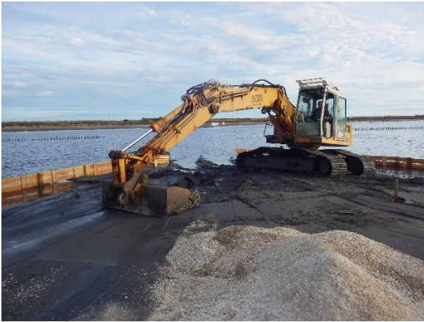
Figure 9-5 : Création de l'îlot du bassin ouest sur l'ancien salin de Villeroy
