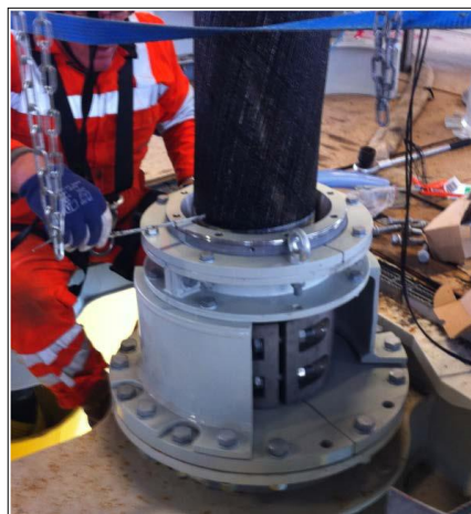
Figure 3-22 : Vue d'un hang-off (PEOPGL, 2017)
