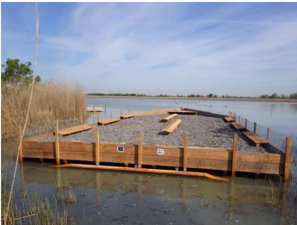
Figure 9-7 : Construction de deux radeaux flottants destinés au Marais du Vigueirat et à la Poudrerie royale de Saint-Chamas et Miramas.
