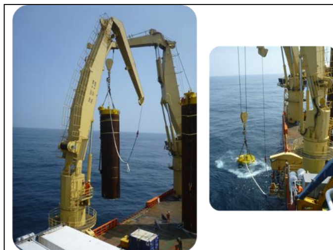
Figure 3-14 : Mise à l'eau des ancres (PEOPGL, 2017)
