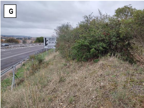
Talus autoroutier non propice à la présence de zone humide
