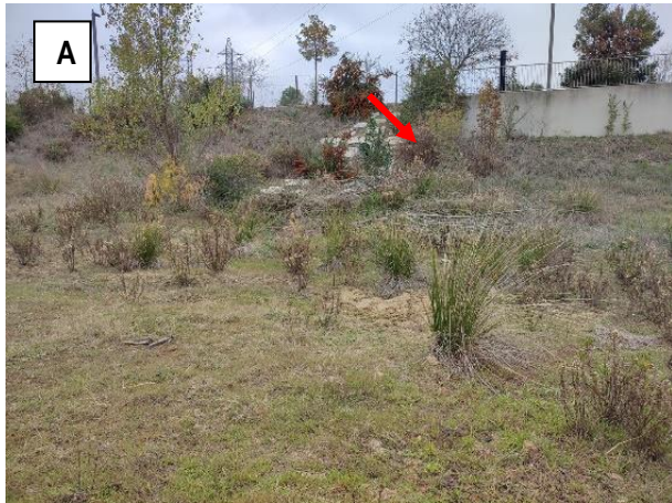
Arrivée d'eau dans le bassin d'infiltration depuis un parking conduisant au développement épars de Joncs en contrebas
