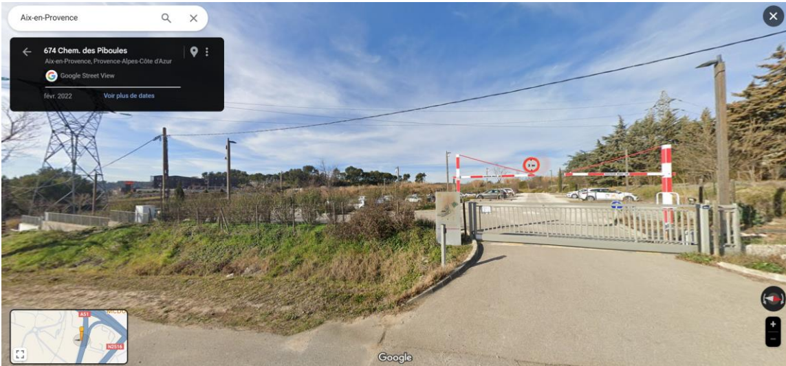
Zone d'installation de chantier 2 (source : google street view, août 2024)
