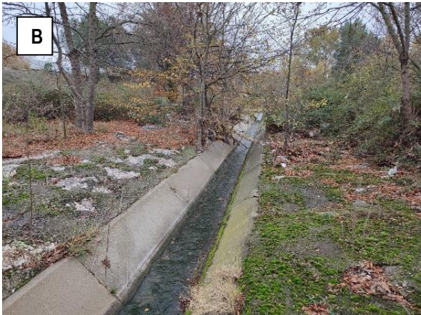
Aperçu du canal bétonné traversant le bassin d'infiltration, partiellement recouvert de bitume en rive gauche
